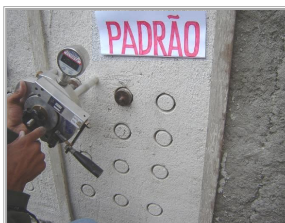
Foto 11 - Execução do ensaio no painel com argamassa “padrão”.
