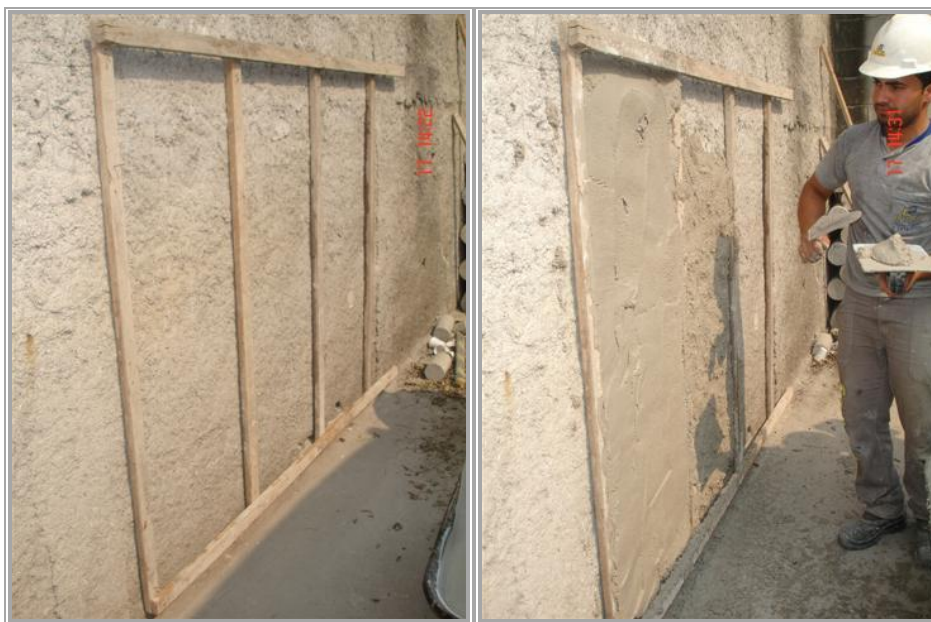
Foto 6 – Vista da parede existente: divisão em painéis e lançamento da argamassa.
