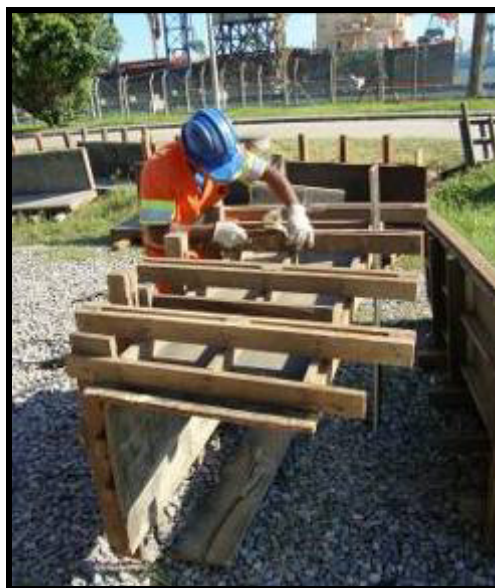
Foto 22 – Fabricação das formas nos berços
