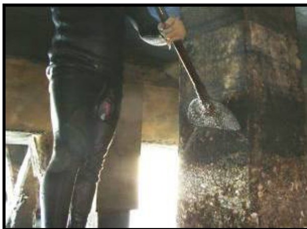
Foto 4 – Limpeza das estacas
