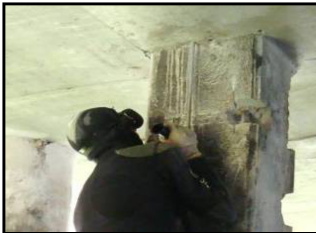
Foto 13 – Perfuração da laje e fixação de arranques
