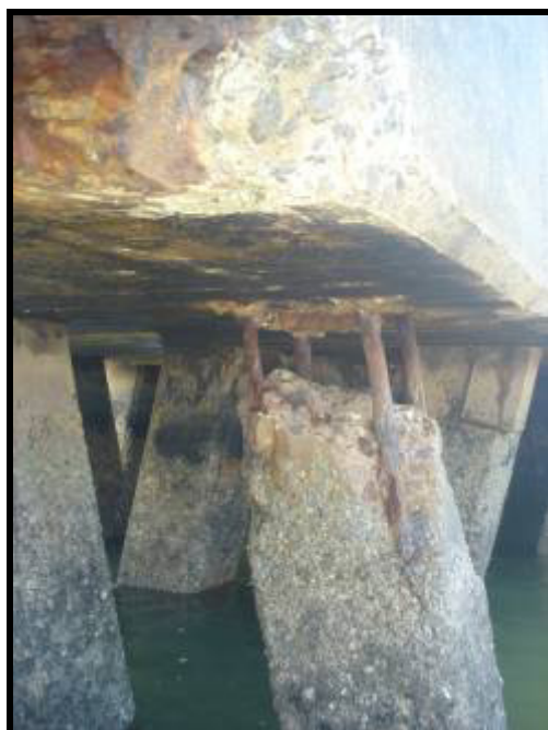
Foto 3 – Estaca tipo 2, estaca antes do reparo
