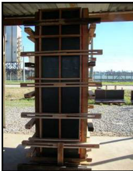
Foto 23 – Forma pronta para instalação`
