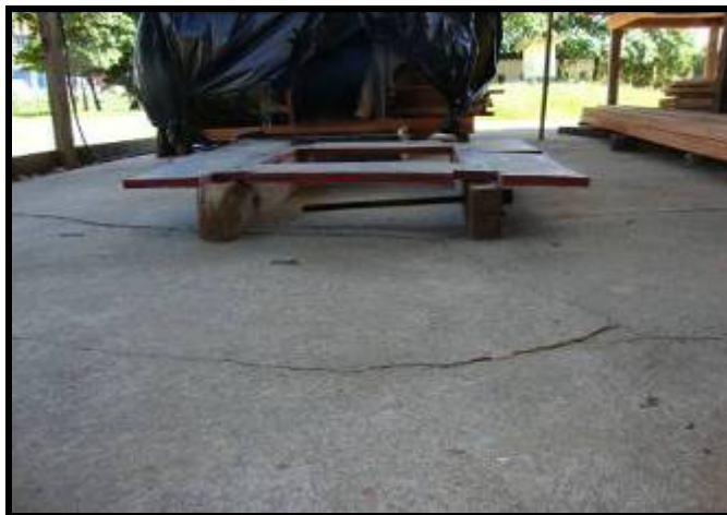
Foto 17 – Base de forma, vista lateral
