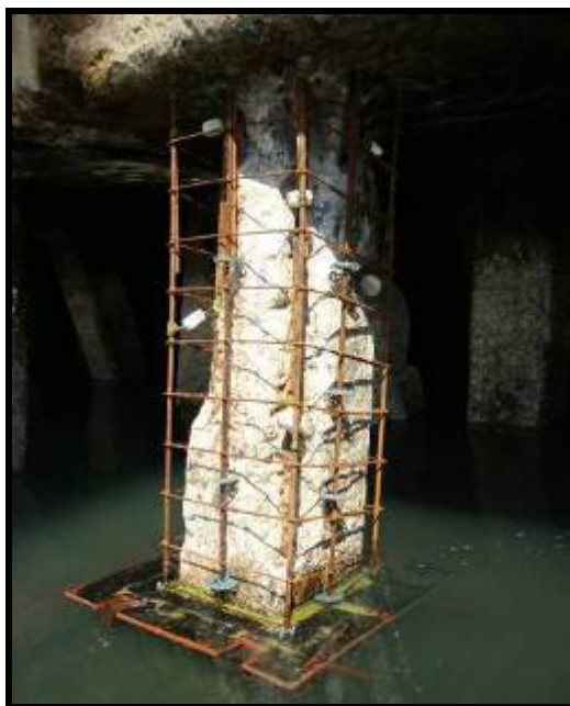
Foto 21 – Armação posicionada na estaca
