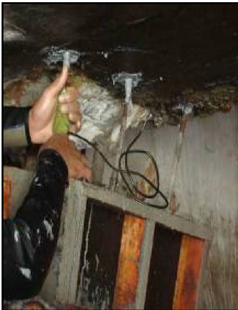
Foto 28 – Fixação com ancoragem química
