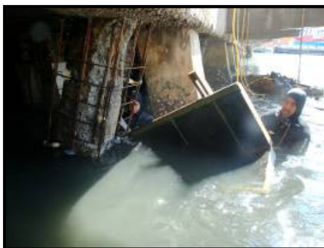
Foto 24 – Instalação da forma
