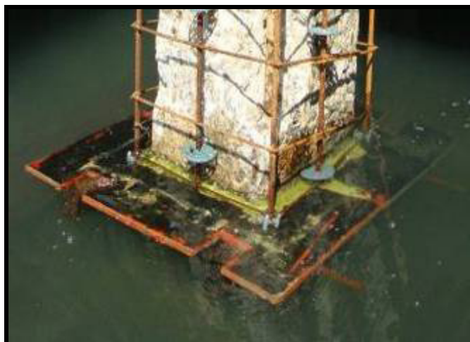
Foto 18 – Base de forma instalada na estaca
