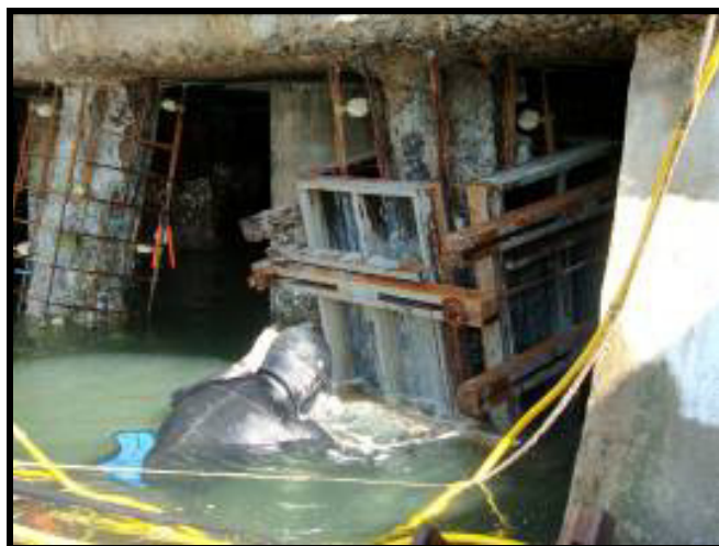
Foto 25 – Ajustes da forma na estaca
