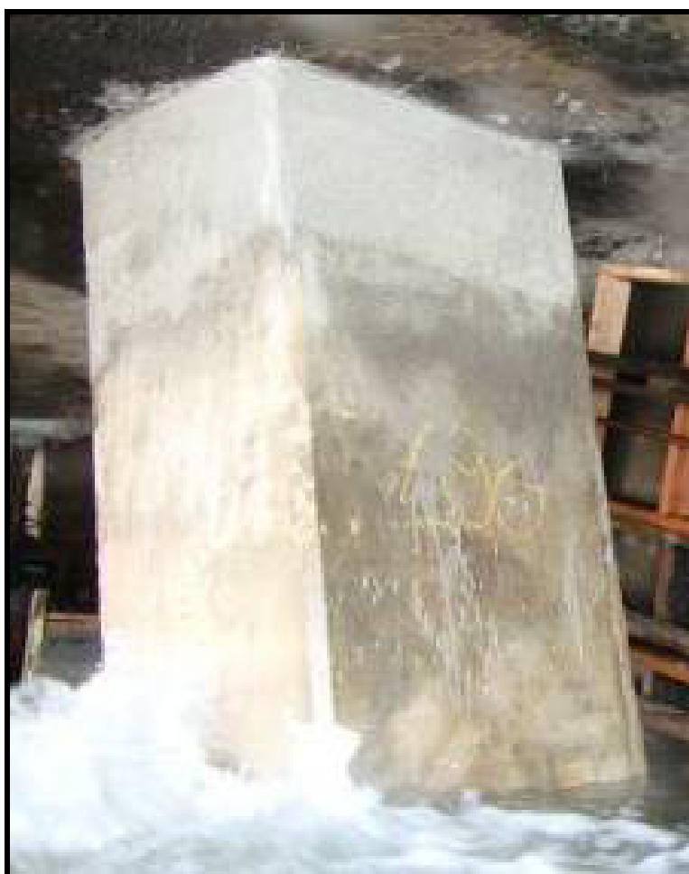
Foto 35 – Complemento final com argamassa tixotrópica
