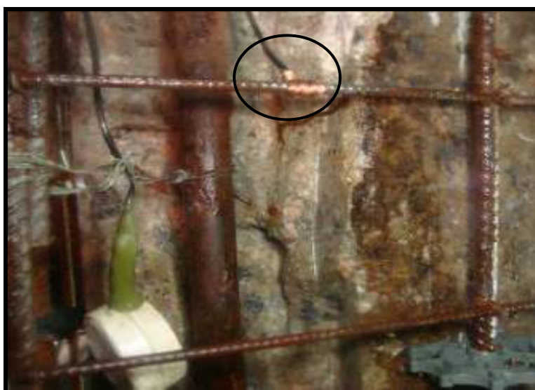
Foto 29 – Detalhe do ânodo instalado e do espaçador
