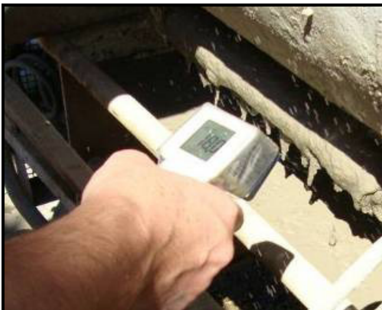
Foto 32 – Verificação da temperatura do graute
