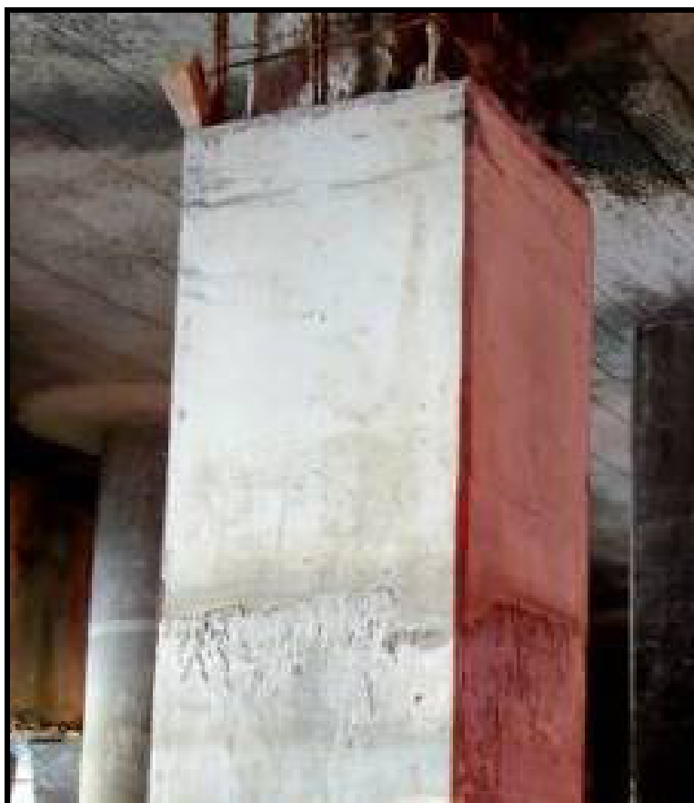
Foto 34 – Estaca desformada
