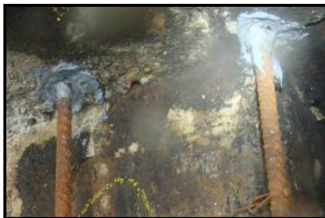
Foto 14 – Ancoragem química dos arranques
