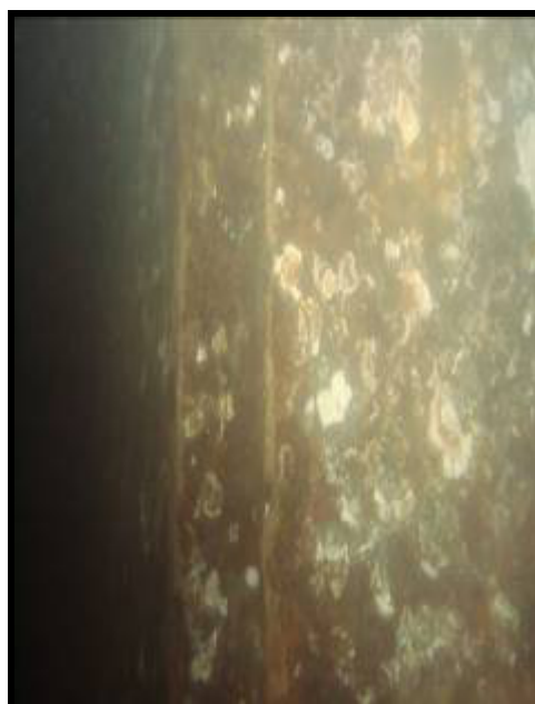
Foto 5 – Estaca cuja limpeza foi concluída
