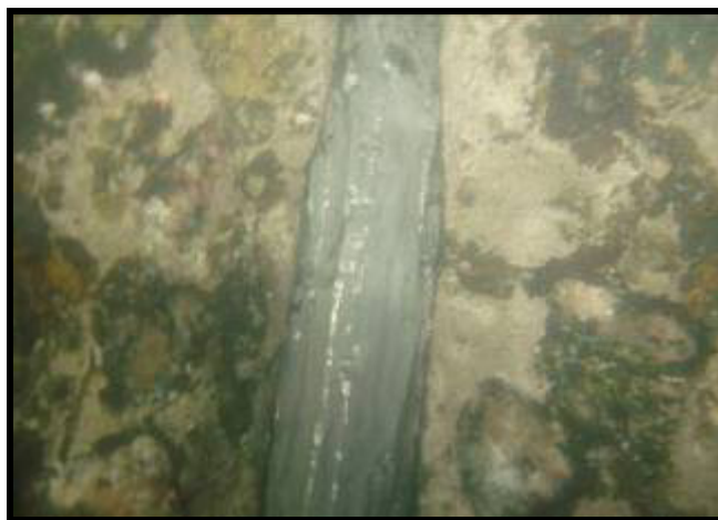
Foto 10 – Armação limpa após hidrojateamento
