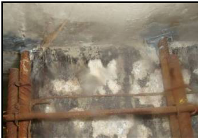
Foto 15 – Ancoragem química dos arranques, outro exemplo.
