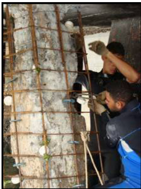
Foto 20 – Colocação dos espaçadores e ânodos
