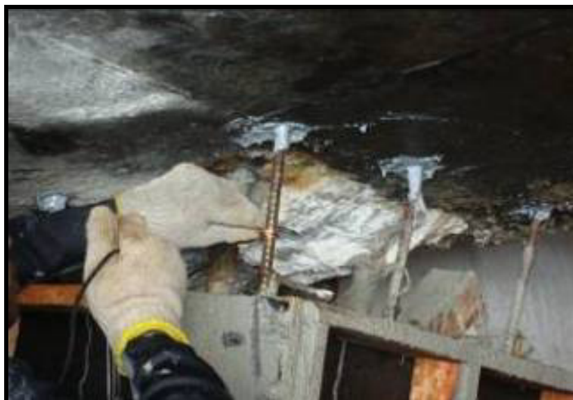
Foto 27 – Fixação com ancoragem química
