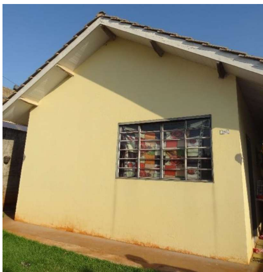
Figura 11: Unidade habitacional do conjunto Jardim Oriental Fonte: AUTORAS, 2019
