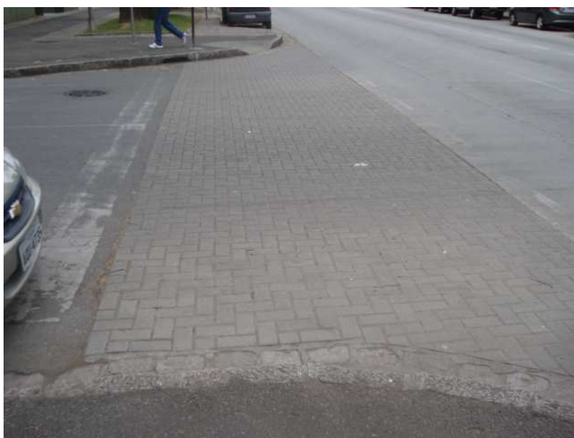
Figura 61: Cruzamento da Av. Iguaçu com a Rua Carneiro Lobo (faixa esq.), condição excelente
