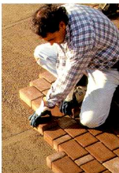
Figura 3. Assentamento manual de blocos (ABCP, 2001)
