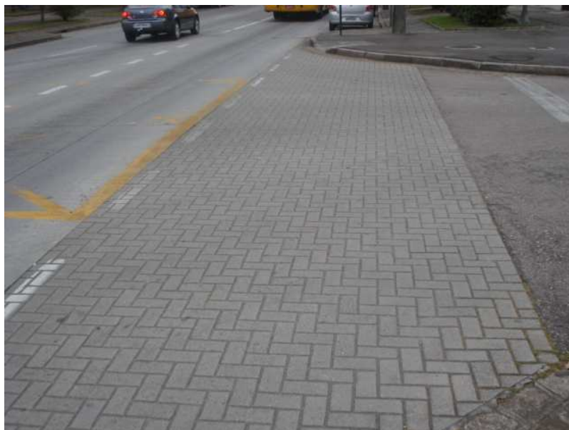
Figura 46: Cruzamento da Avenida Iguaçu com a Rua Maurício Caillet (faixa direita), condição excelente.
