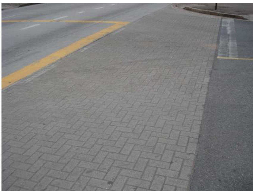
Figura 52: Cruzamento da Av. Iguaçu com a Rua Silveira Peixoto (faixa dir.), condição excelente
