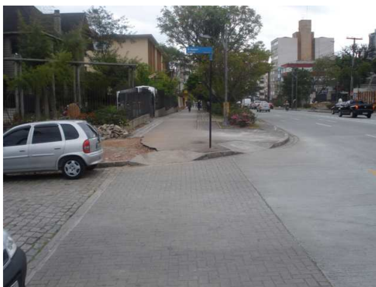
Figura 43: Cruzamento da Avenida Iguaçu com a Rua Pasteur (faixa esquerda), condição muito bom.
