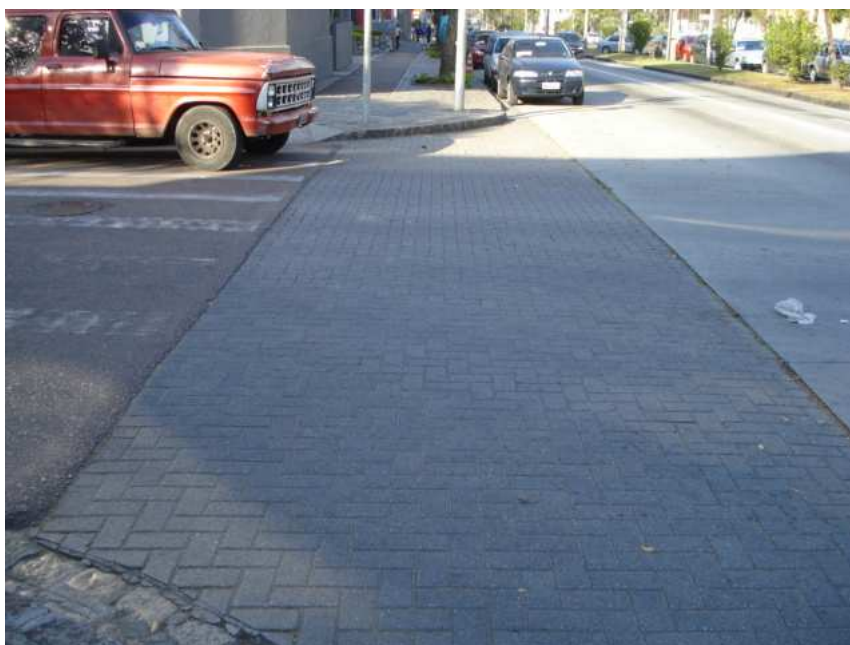
Figura 38: Cruzamento da Avenida Iguaçu com a Rua Lamenha Lins, condição excelente.
