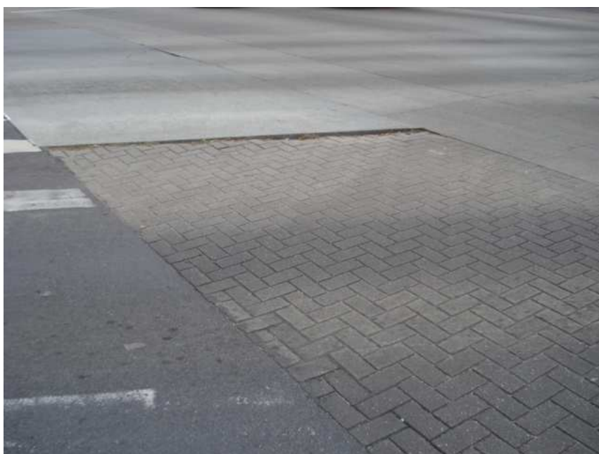
Figura 59: Cruzamento da Av. Iguaçu com a Av Rep. Argentina (faixa esq.), condição boa
