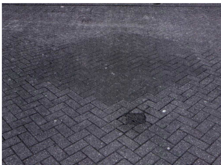
Figura 30. Correção com material diferente– grau de severidade baixo (Interlocking Concrete Block Pavement Distress Guide, 2007)
