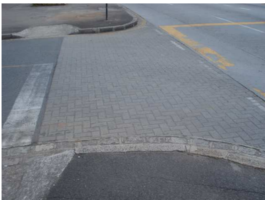
Figura 53: Cruzamento da Av. Iguaçu com a Rua Silveira Peixoto (faixa esq.), condição excelente
