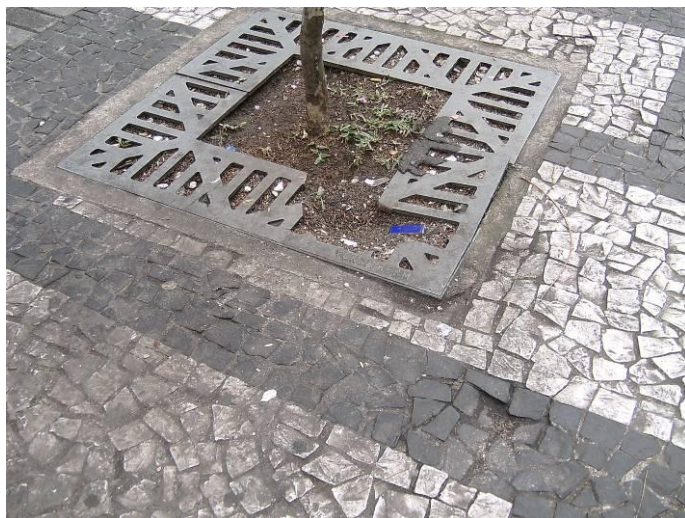
Figura 15. (Foto 72 – Q02) Petit Pave com irregularidades.
