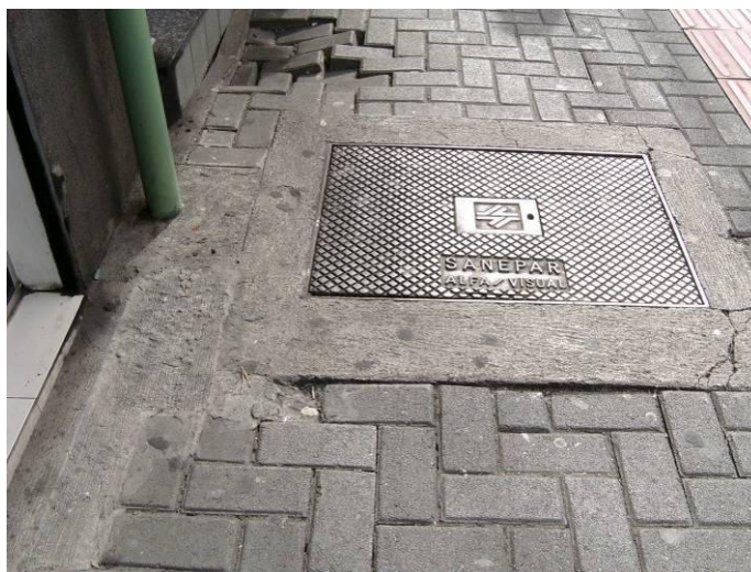
Figura 75. (Foto 09 – Q07B) Paver com irregularidades.
