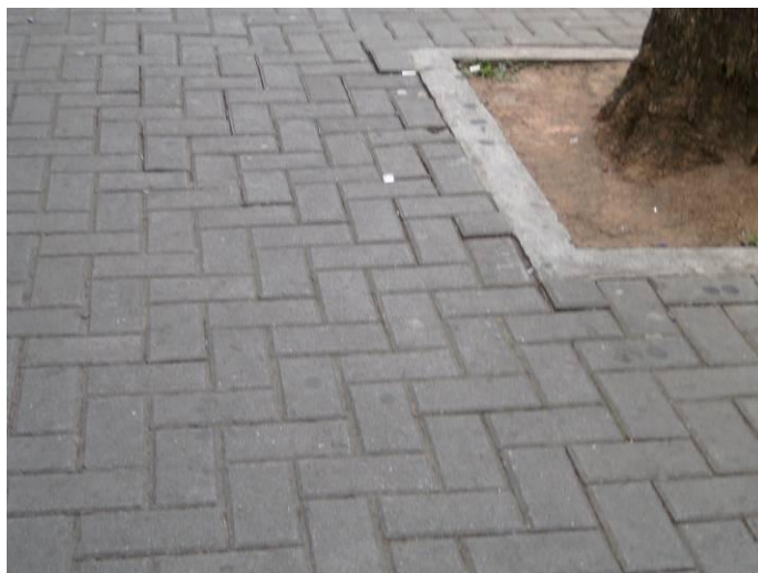
Figura 46. (Foto 55 – Q05A) Paver com deformação por raízes.
