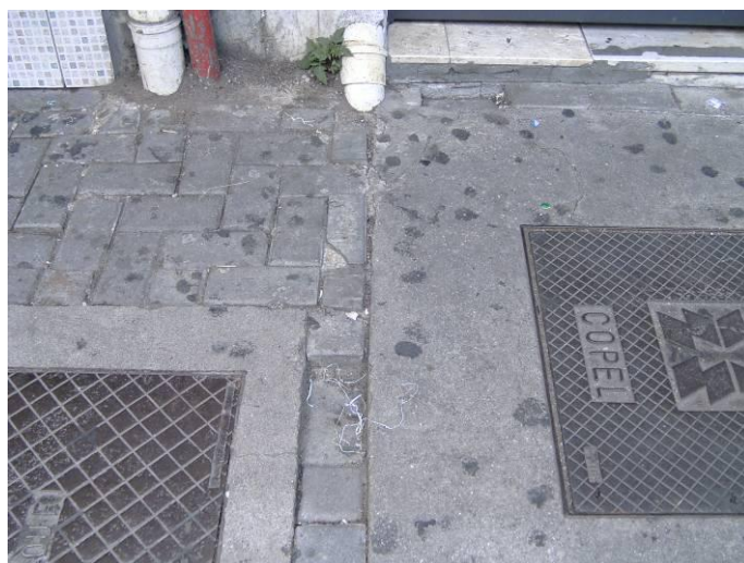
Figura 26. (Foto 10 – Q03) Paver com irregularidades.
