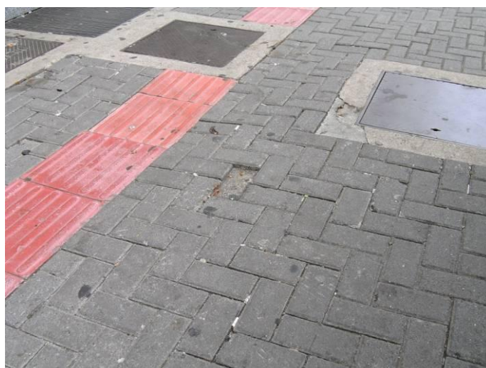
Figura 40. (Foto 56 – Q04B) Paver com irregularidades.
