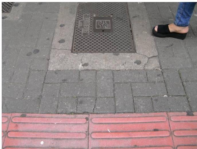
Figura 49. (Foto 42 – Q05B) Paver e Bordas das Tampas com trincas.
