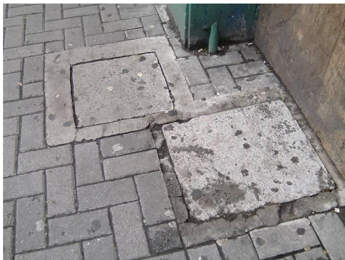
Figura13. (Foto 15 – Q01) Tampa com irregularidades.
