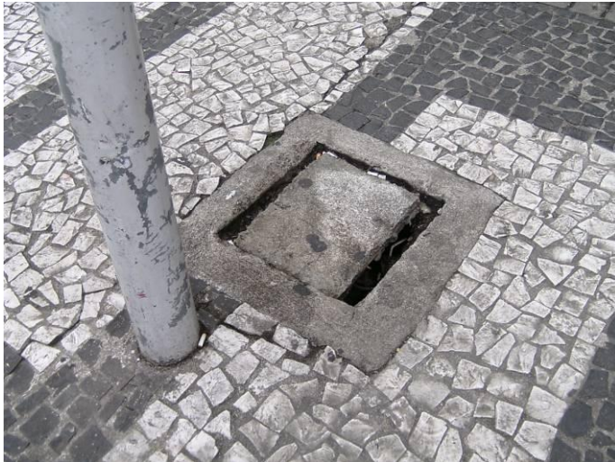
Figura 11. (Foto 08 – Q01) Tampa com irregularidades.
