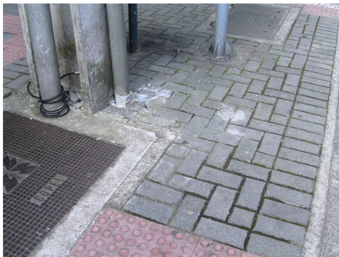
Figura 79. (Foto 110 – Q08) Paver com irregularidades.
