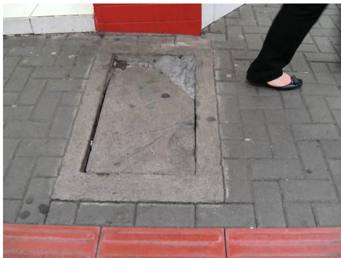
Figura 46. (Foto 55 – Q05A) Paver com deformação por raízes.
