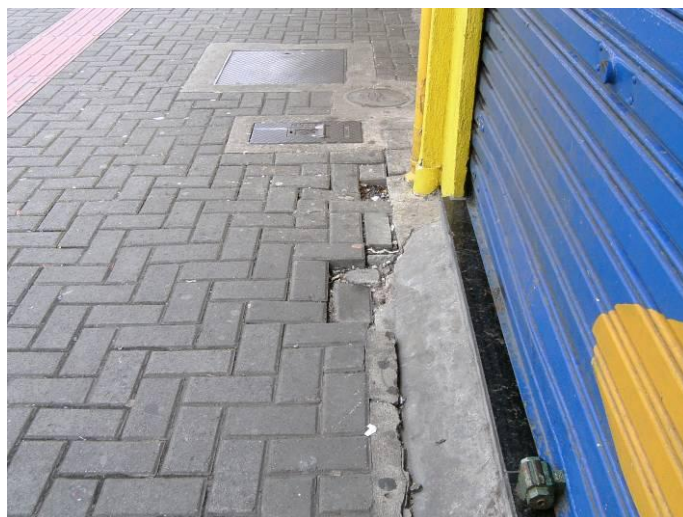
Figura 23. (Foto 22 – Q03) Paver com irregularidades.
