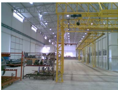
Figura 38 - Vista Interna dos fundos do galpão em direção a frente – Nov./2010.
