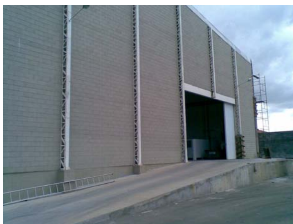
Figura 35 - Fachada do galpão – Nov./2010.
