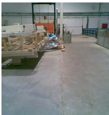
Figura 37 - Vista Interna do galpão – Fase 1 para 2 de concretagem – Nov./2010.
