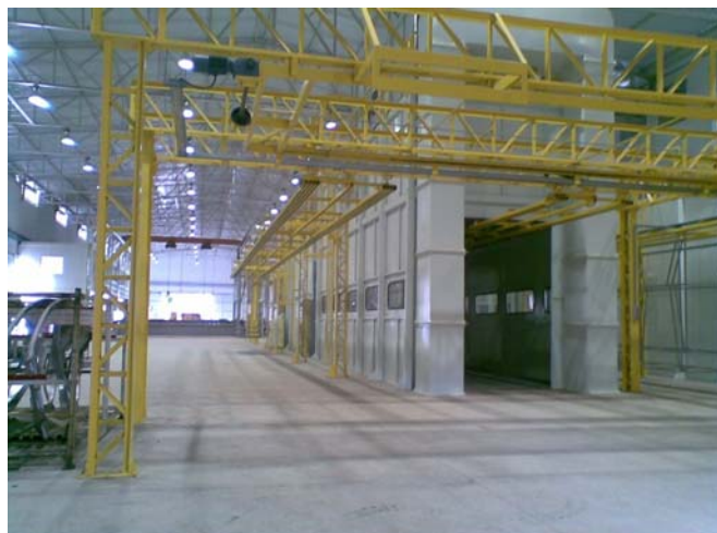
Figura 36 - Vista Interna do galpão – Fase 1 de concretagem – Nov./2010.
