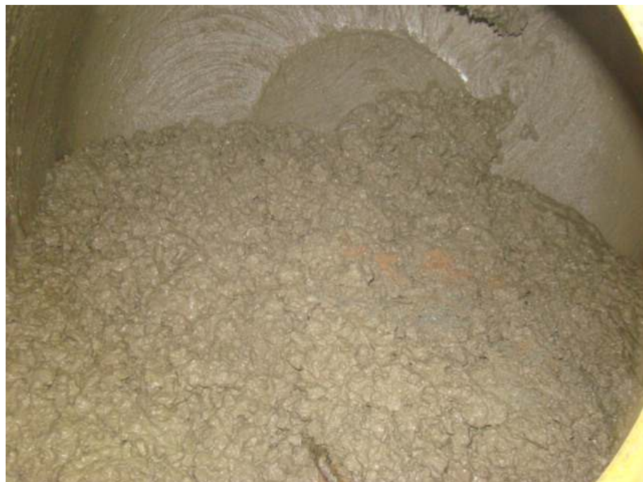
Foto 2. Vista do concreto na etapa do amassamento.
