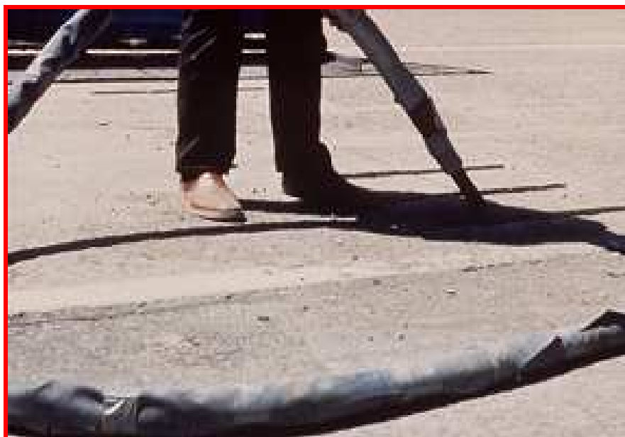
Figura 8 - Limpeza com jato de ar (GIUBLIN, 2009)
