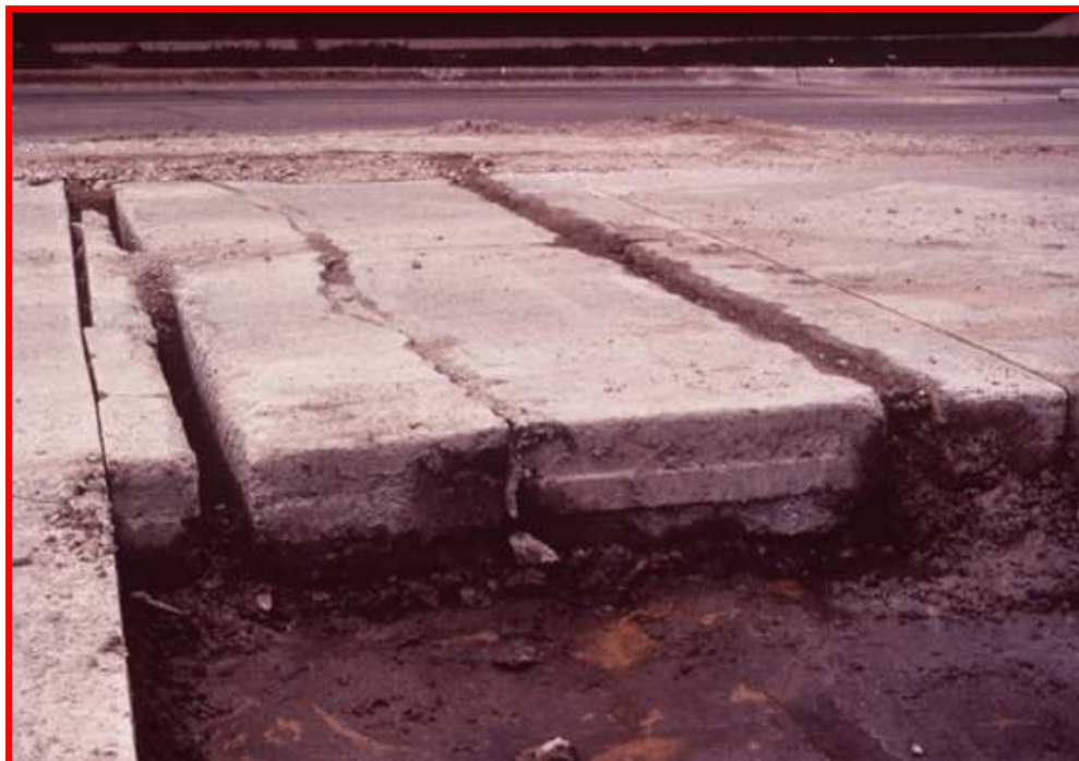
Figura 33 - Cortes controlados para retirada de placa. (GIUBLIN, 2009)
