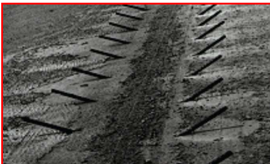
Figura 17 - Colocação das barras e preenchimento com resina epoxídica (IGGA, 2010)
