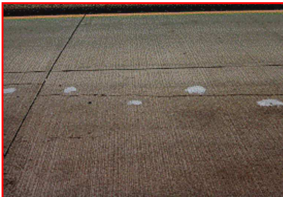
Figura 18 - Visão geral após a obturação dos buracos (IGGA, 2010)
