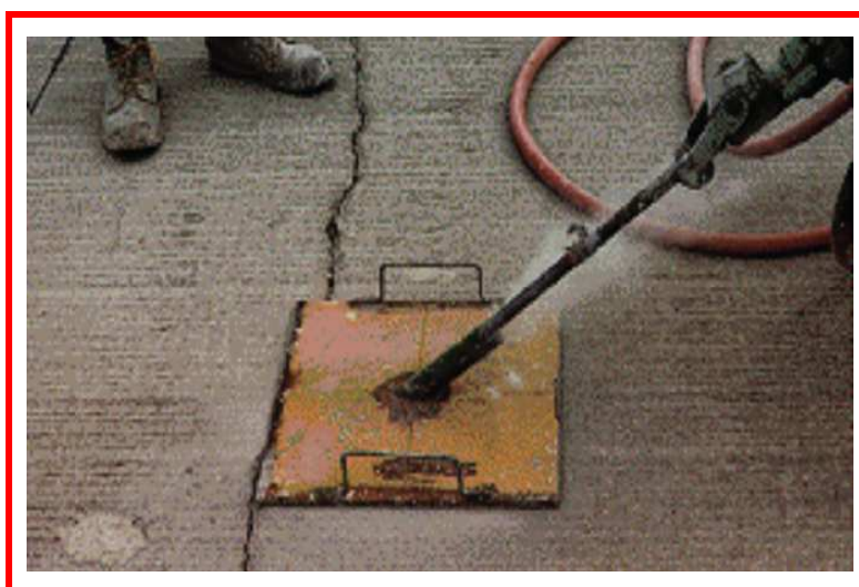
Figura 15 - Execução de furação para instalação das barras (IGGA, 2010)
