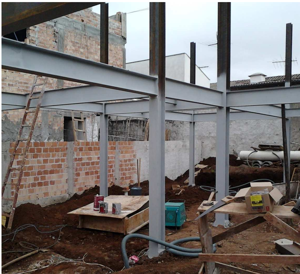
FIGURA 15: Execução da estrutura metálica do primeiro pavimento.
