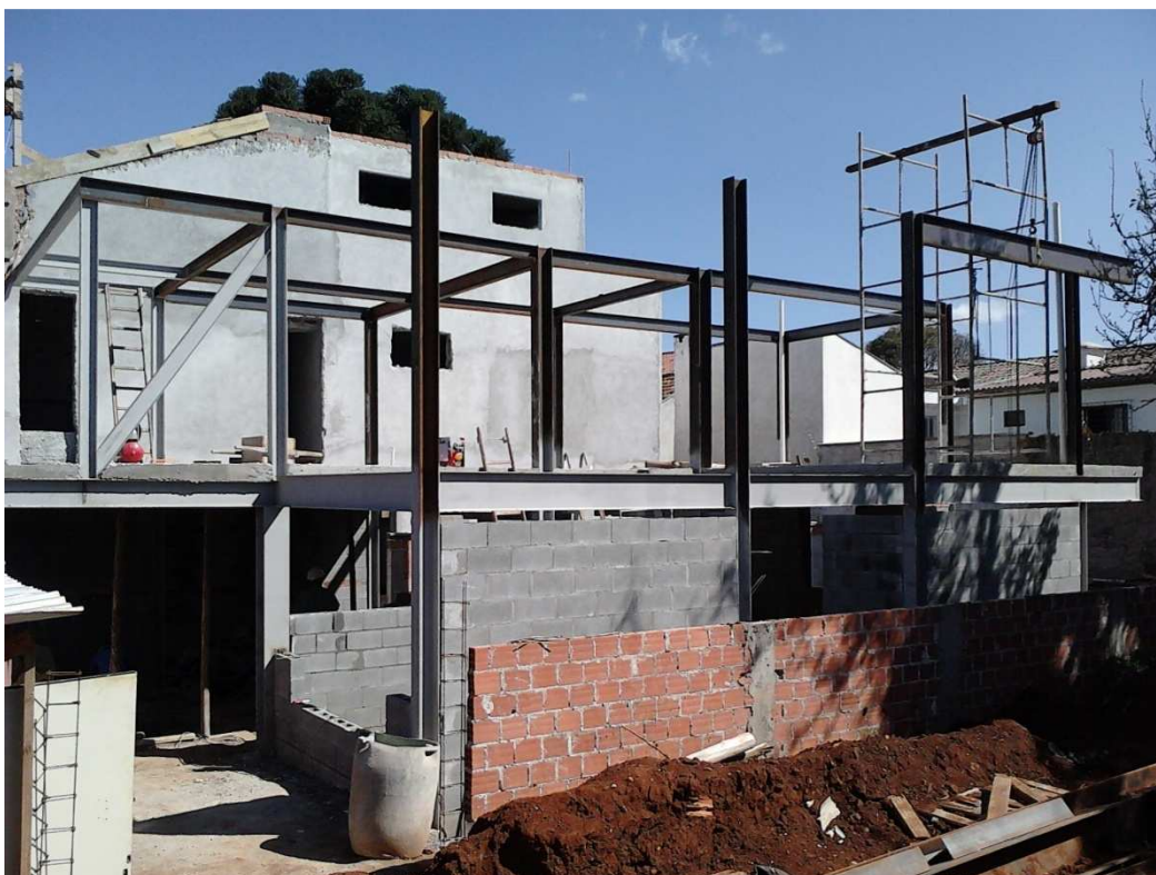
FIGURA 16: Execução de diversas atividades em concomitância
