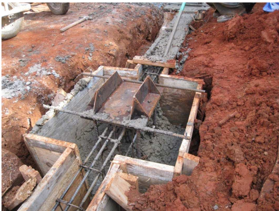
FIGURA 13: Foto tirada "in loco" do bloco com a armadura do baldrame com a placa de ligação.
