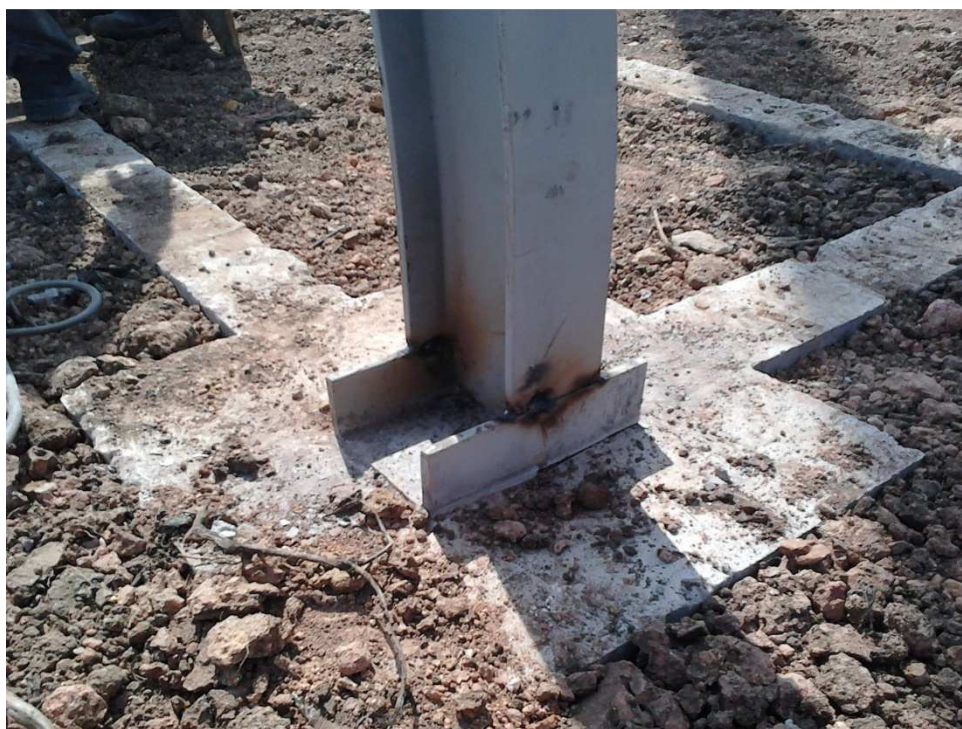
FIGURA 14: Foto tirada do bloco pronto e com o perfil I já instalada
