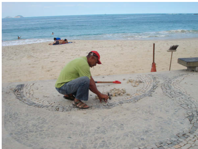
FIGURA 3.10 – Recomposição do Pavimento.
