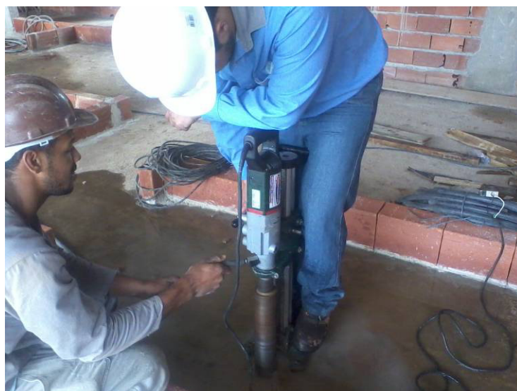
Fotografia 11 – Extração de testemunhos na laje maciça do edifício.
