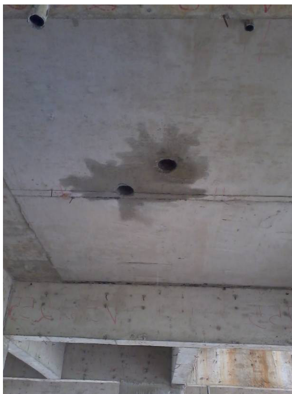
Fotografia 12 – furos decorrentes da extração de testemunhos
