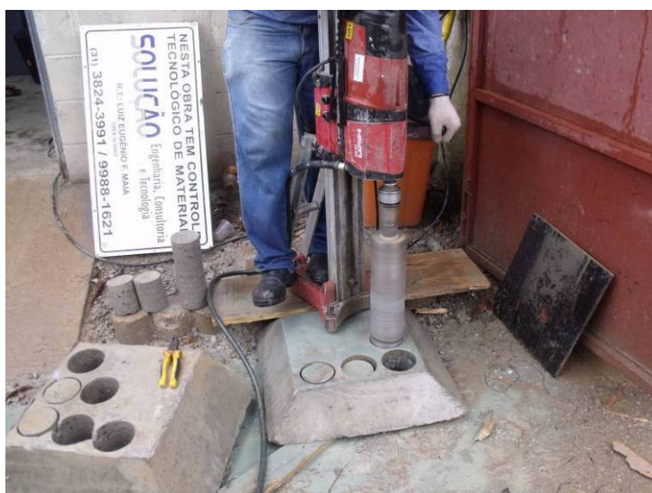
Fotografia 05 – Extração de corpo de prova
