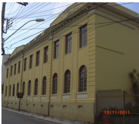
Figura 6 - Vista para fachada da rua Barão de Itapemirim
