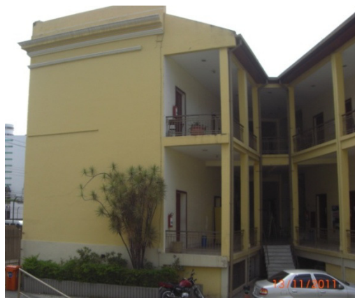
Figura 7 - Vista de parte da fachada interna do edifício
