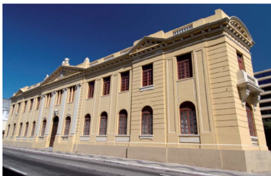
Figura 4 - Vista frontal do prédio da Fafi (ALMEIDA, 2009)
