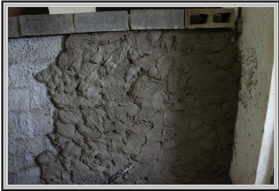
Foto 8 – Vista da aplicação da argamassa no painel
