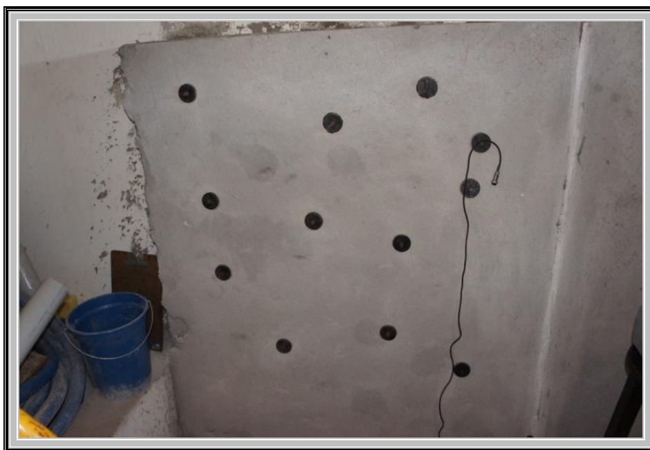
Foto 23 – Vista do distanciamento da retirada de cada testemunho.
