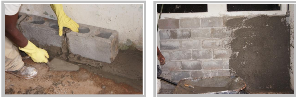
Foto 4 e 5 – Vista da execução dos painéis em construção
