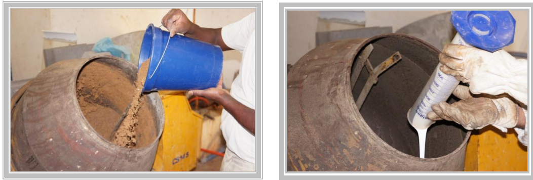
Foto 6 e 7 – Vista da mistura da argamassa na betoneira, em detalhe a adição da areia e resina (base PVA)
