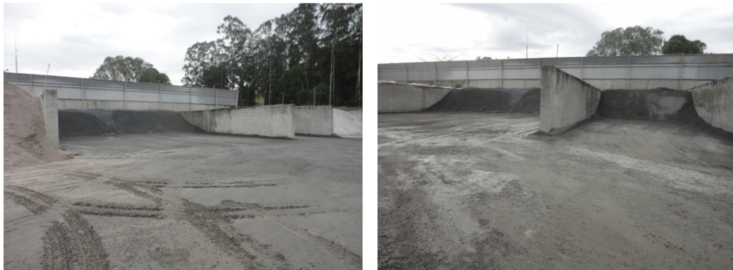
Figuras 5 e 6 - Baias de estocagem de agregados
