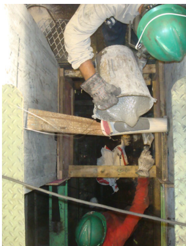
Foto 01 – Lançamento do Material em local confinado com uso de cachimbo
