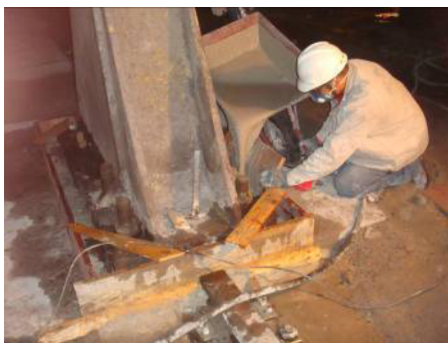
Foto 02 – Lançamento do Material
