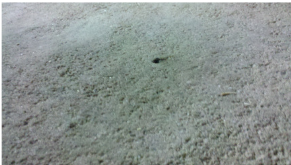
Foto 10: Superfície com rugosidade uniformemente distribuída
