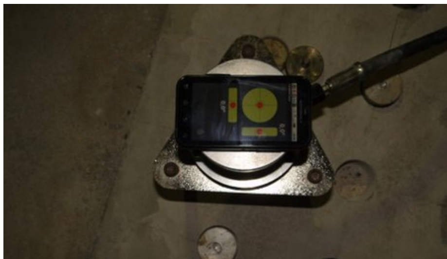
Foto 31: Nivelamento do equipamento de arrancamento
