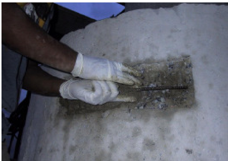
Foto 4: Recomposição da estrutura
