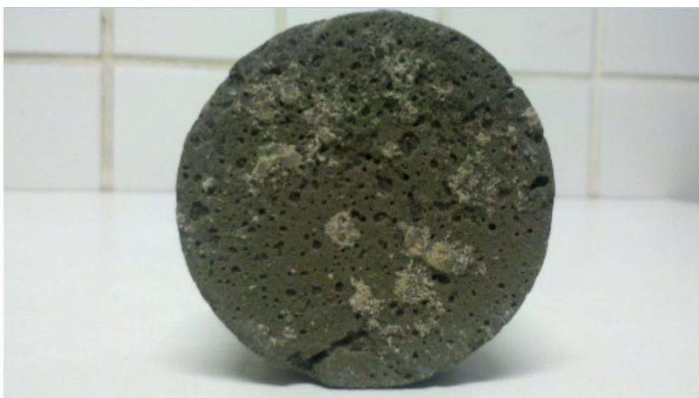
Foto 25: Interface de ruptura do CP rompido durante o processo de corte.
