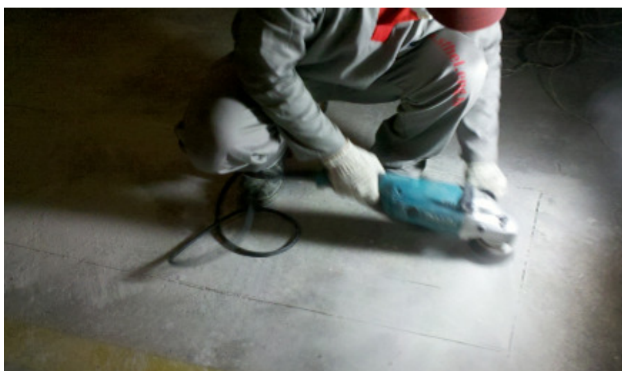
Foto 9: Desbaste superficial com lixadeira elétrica e rebolo abrasivo
