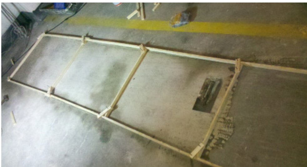
Foto 11: Detalhe da fôrma sendo preparada
