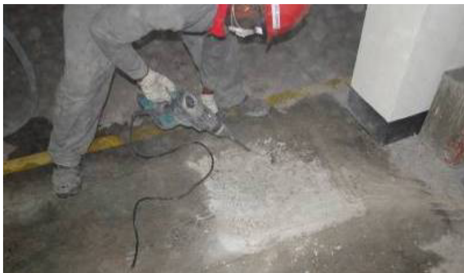
Foto 8: Apicoamento de concreto com rompedor elétrico
