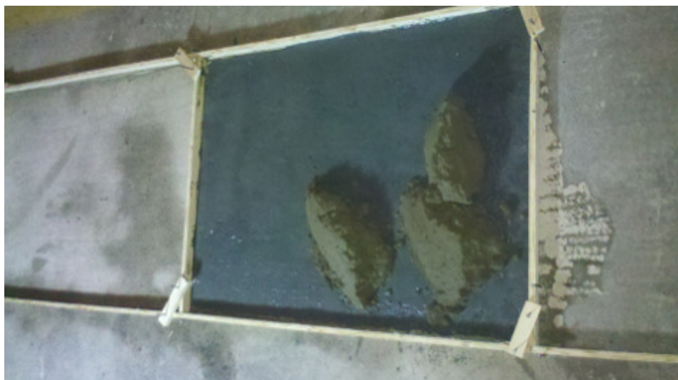
Foto 15: Argamassa polimérica sendo aplicada sobre o adesivo epóxi
