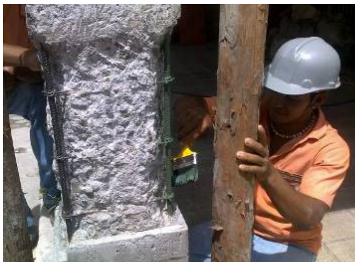
Foto 3: Proteção das armaduras com inibidor de corrosão
