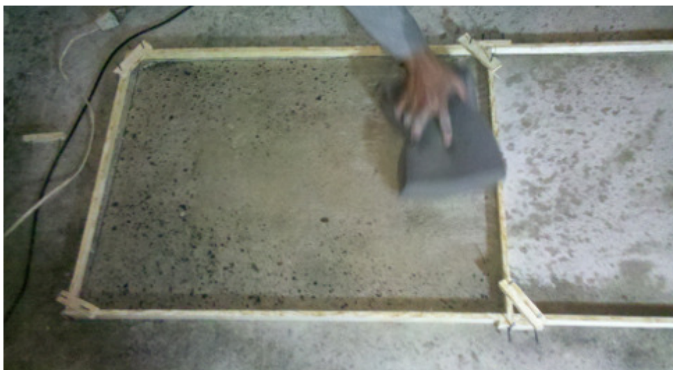
Foto 18: Superfície sendo previamente umidecida
