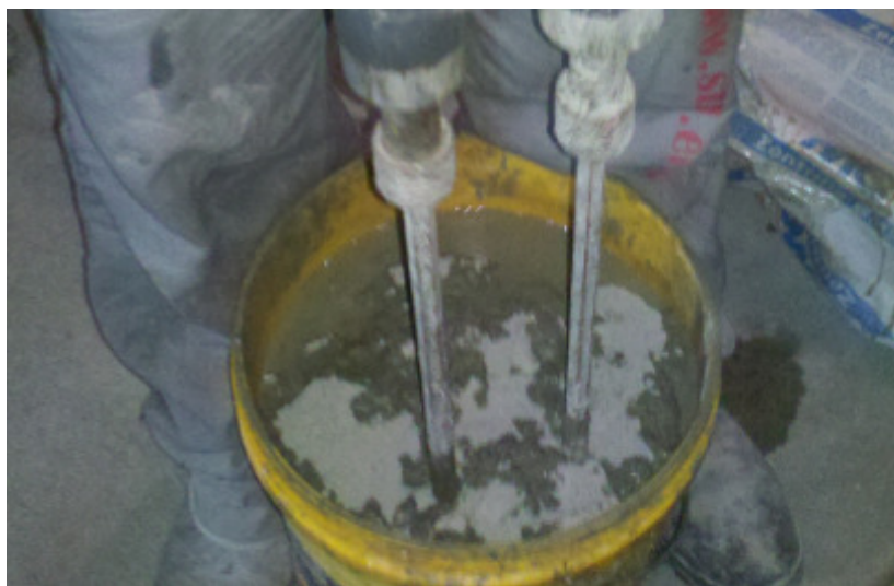
Foto 14: Mistura da argamassa polimérica Zentrifix GM2 com misturador de haste dupla
