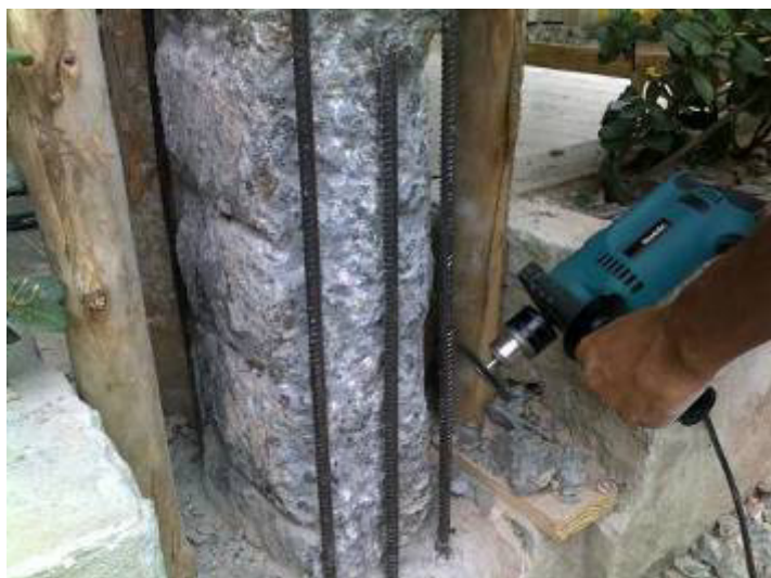
Foto 2: Limpeza da armadura a armadura
