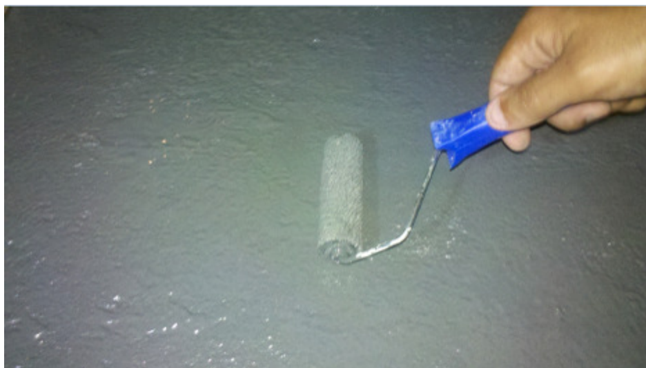
Foto 13: Adesivo epóxi sendo aplicado com rolo
