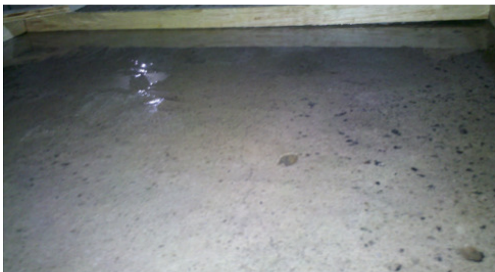
Foto 19: Lâmina de água utilizada para a saturação do substrato
