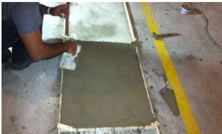
Foto 16: Nivelamento da argamassa polimérica
