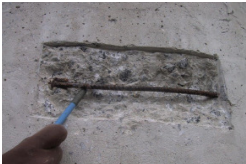
Foto 1: Remoção do concreto ao redor das armaduras
