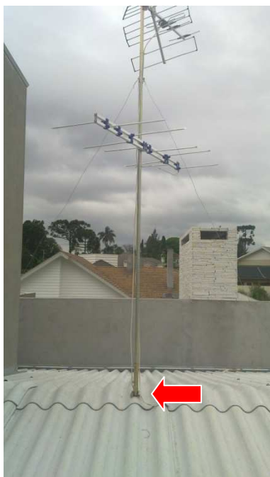
Figura 21 - Antena fixada na estrutura da cobertura, atravessando a telha.
