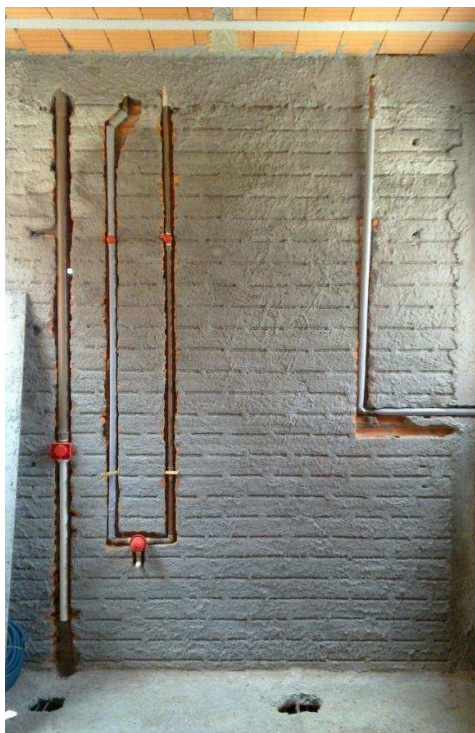
Figura 12 - Tubulações hidráulicas embutidas na alvenaria antes do revestimento.
