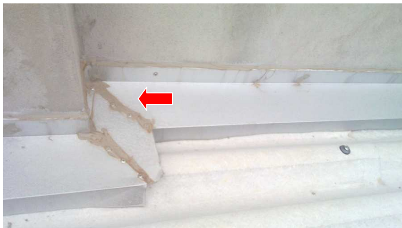
Figura 23 - Detalhe da emenda com elastômero a base de poliuretano entre as chapas galvanizadas.
