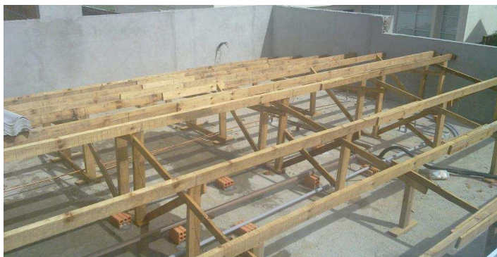
Figura 19 - Estrutura de madeira da Residência A.P.
