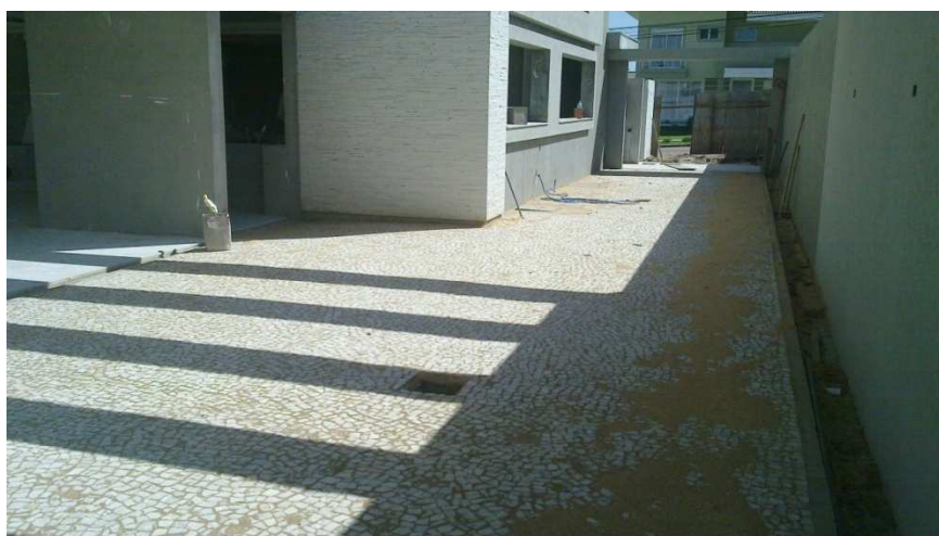
Figura 26 - Corredor de acesso de veículos com revestimento em pedra portuguesa: dimensionado para ser utilizado por veículos leves.
