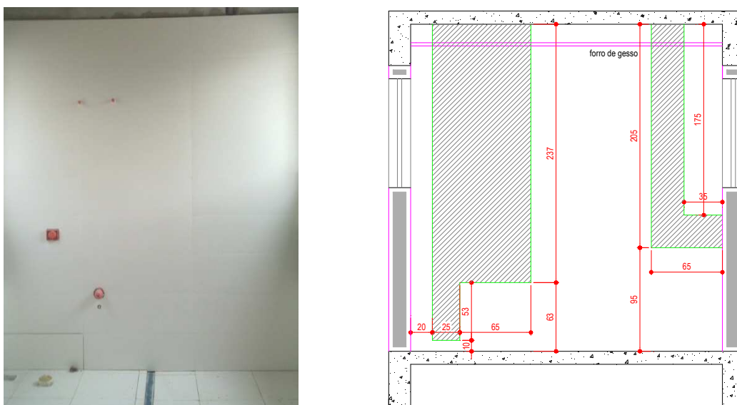
Figura 3a e 3b - 3a - Parede de um banheiro (pontos aparentes, tubulações ocultas); 3b - Exposição das tubulações ocultas em uma das paredes do banheiro.
