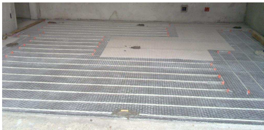
Figura 25 - Sistema Hotfloor: resistências elétricas que serão capeadas com argamassa de contrapiso (As áreas que não possuem resistência são os locais onde haverá móveis fixos)
