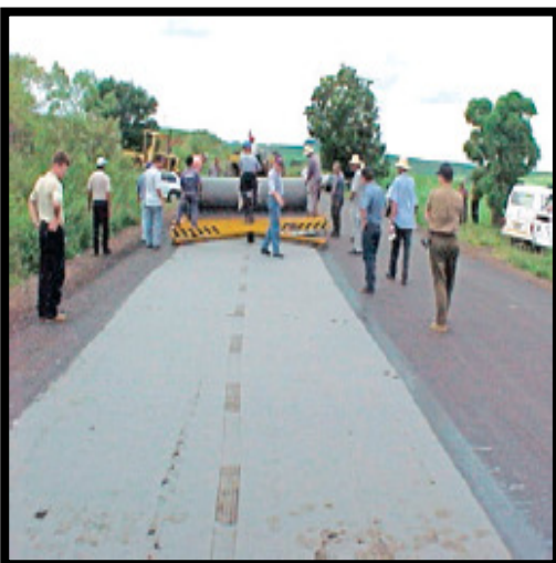
(c) Aplicação do geotêxtil
