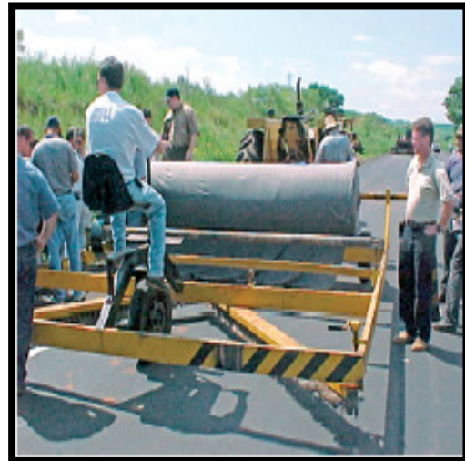
(b) Equipamento aplicador do geotêxtil
