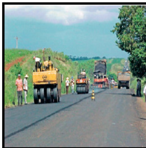
(h) Execução da camada de recapeamento
