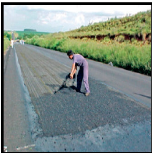
(g) Espalhamento de pedrisco impregnado com ligante asfáltico
