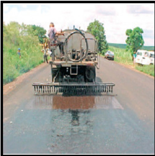
(a) Execução da pintura de ligação
