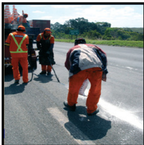
(c) Aplicação de cal para proteção caso se aplique uma nova camada de revestimento asfáltico
