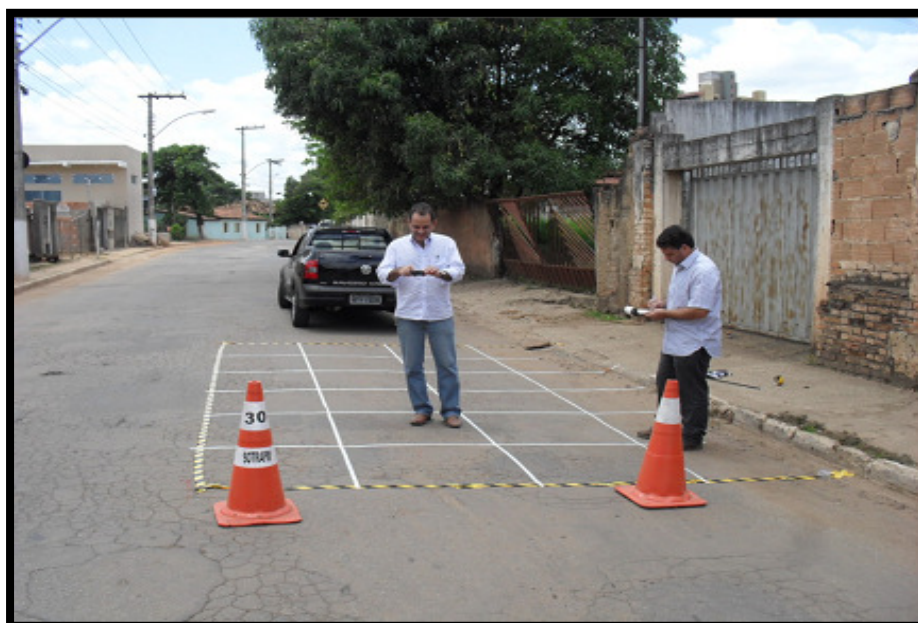
Foto 69 – Vista frontal do pavimento asfáltico estação 11 – Lado Direito – sentido Bairro/Centro
