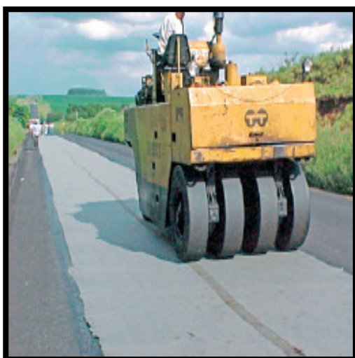
(e) Compressão para a aderência à pintura de ligação
