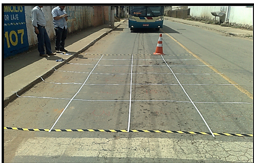
Foto 67 – Vista frontal do pavimento asfáltico estação 1 – Lado esquerdo – sentido Bairro/Centro
