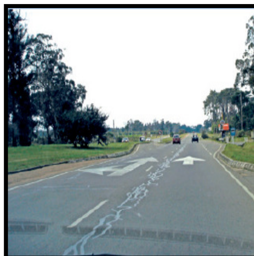
(d) Revestimento após selagem de trincas
