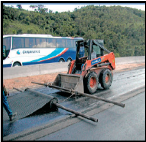
(c) Aplicação da geogrelha
