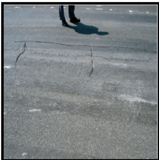
(a) Abertura de trinca para selagem e limpeza
