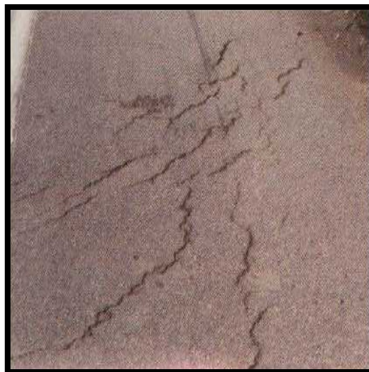
Foto 19 – Trincamento Parabólico
