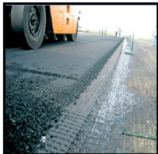
(f) Compactação da camada de Recapeamento
