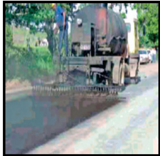
(b) Execução de pintura de ligação
