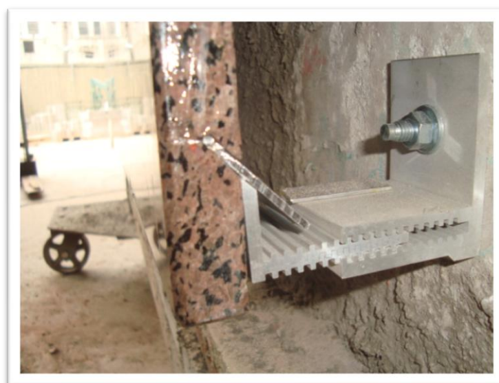
Figura 20: Insert Metálico fixado na placa de granito.
