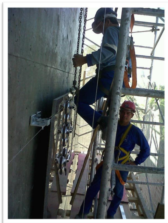
Figura 32:Granito colocado na fachada
