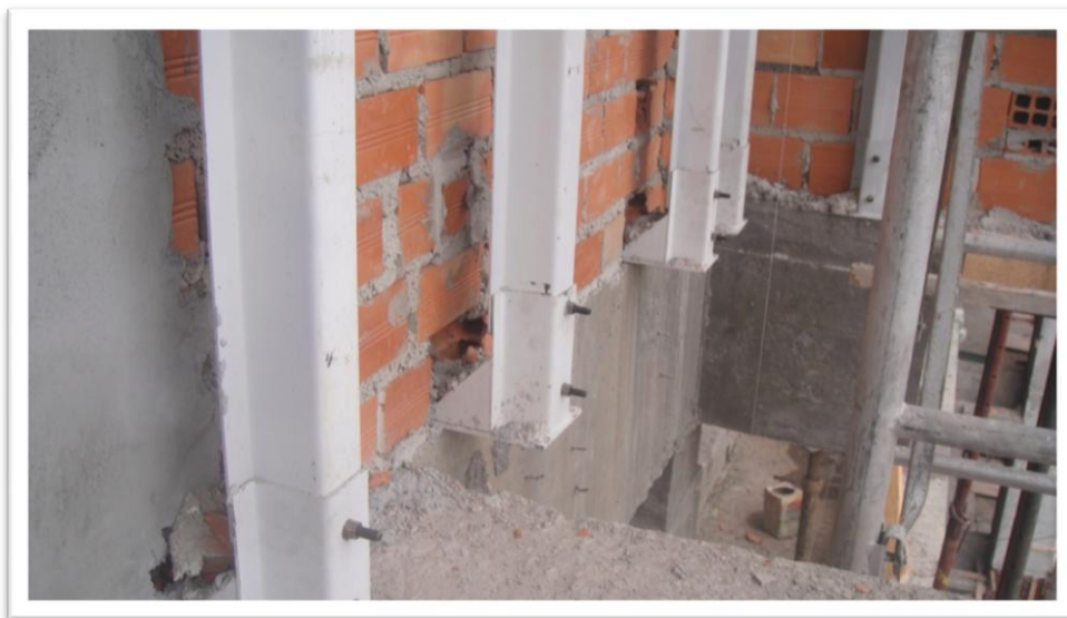
Figura 27: Estrutura em frete a paredes de alvenaria
