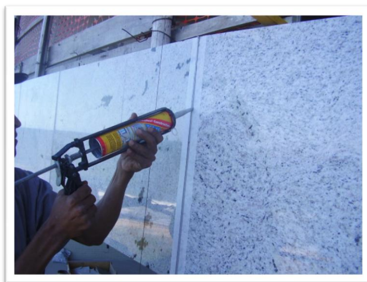
Figura 17: Aplicação de mastique entre as placas
