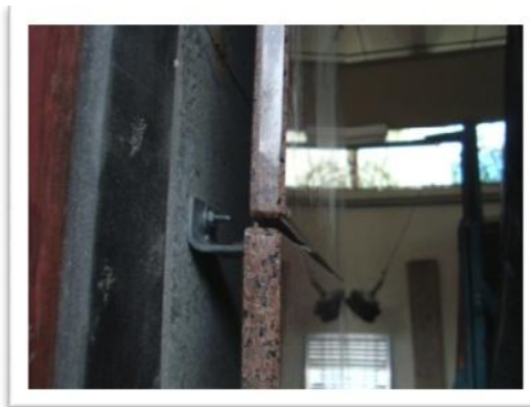
Foto nº 03 – Fixação entre placas
