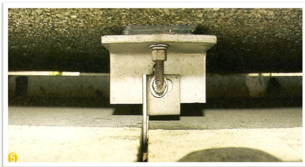
Figura 16: Regulagem e alinhamento final da placa
