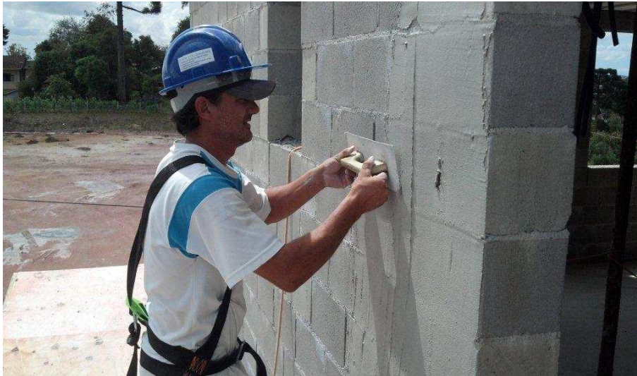
Figura 15 - Revestimento da parede externa em alvenaria estrutural.
