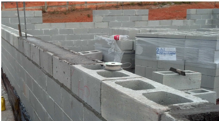
Figura 9 - Levantamento da alvenaria estrutural.
