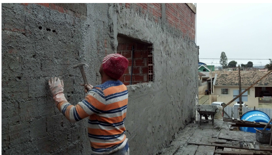
Figura 13 - Revestimento da parede externa em alvenaria convencional.
