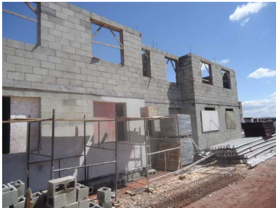
Figura 5 - Obra utilizando alvenaria estrutural.
