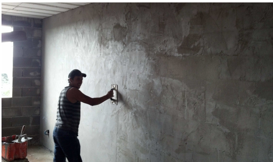
Figura 14 - Revestimento da parede interna em alvenaria estrutural.
