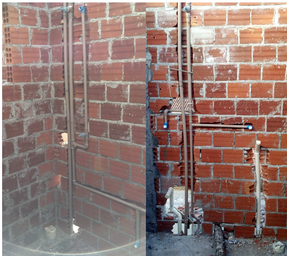
Figura 17 - Instalações hidráulicas em alvenaria convencional.
