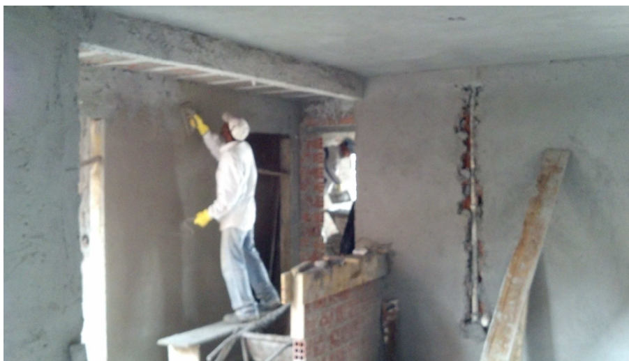
Figura 12 - Revestimento da parede interna em alvenaria convencional.
