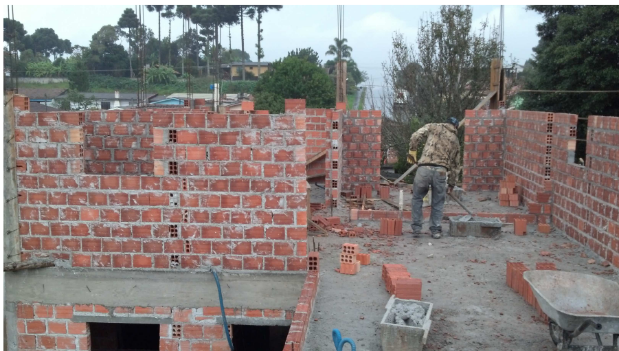
Figura 7 - Levantamento da alvenaria convencional.
