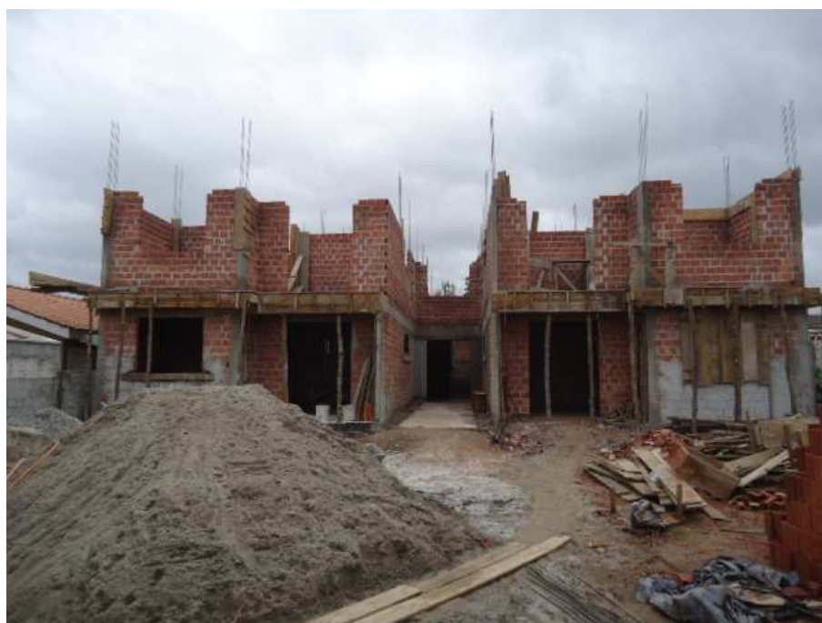
Figura 6 - Obra utilizando alvenaria convencional.
