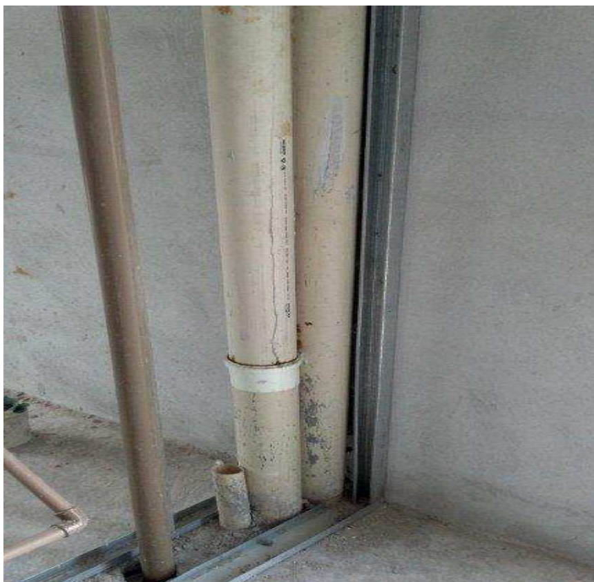
Figura 18 - Instalações hidráulicas em alvenaria estrutural.
