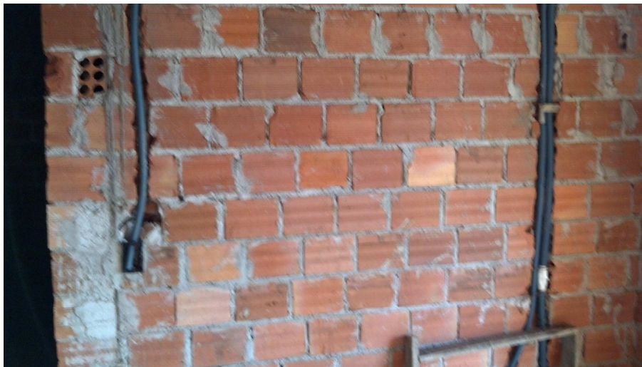
Figura 19 - Instalações elétricas em alvenaria convencional.
