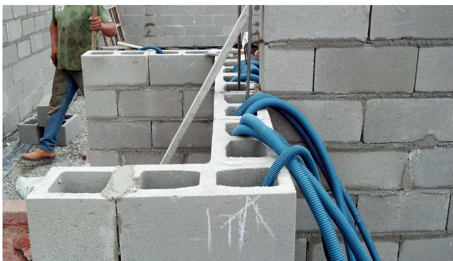
Figura 21 - Instalações elétricas em alvenaria estrutural.
