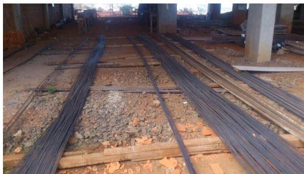
Figura 4: Estocagem dos vergalhões de aço no canteiro de obra (Fonte: O autor)
