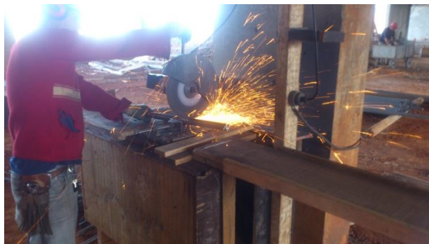
Figura 5: Corte dos vergalhões de aço (Fonte: O autor)
