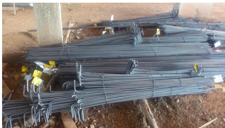
Figura 9: Aço fornecido pré-cortado e pré-dobrado (Fonte: O autor)
