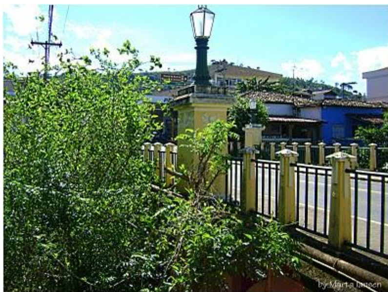
Figura 4 - Primeira Ponte em Concreto Armado do Estado de São Paulo. Fonte: Marta Iansen (2010).
