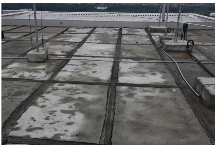
Figura 26. Detalhe de juntas e bases de antenas. Fonte: Autores, 2012.
