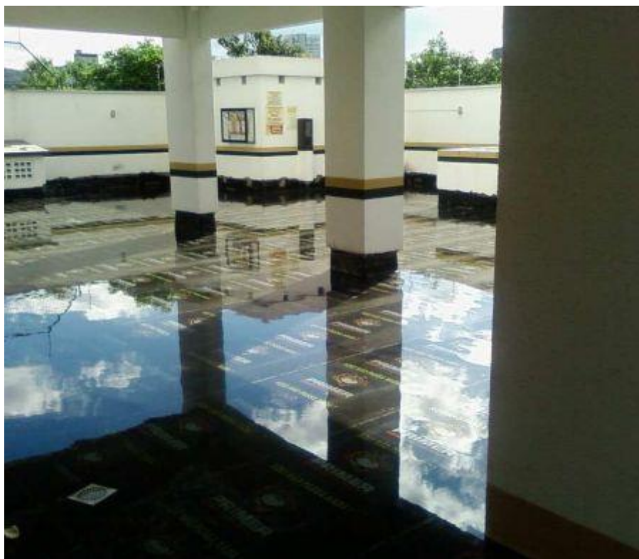
Figura 24. Teste de Estanqueidade.Fonte: Primer
