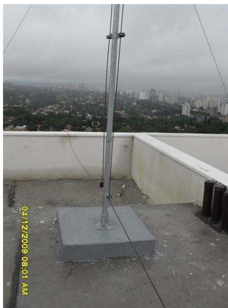
Figura 31. Fixação adequada de elemento sobre o sistema de impermeabilização. Fonte: Autores, 2012.
