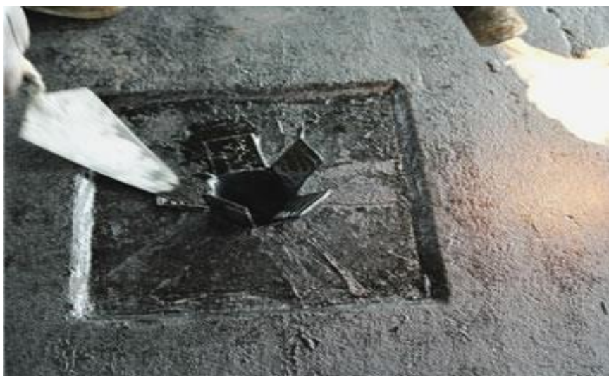
Figura 20. Detalhe de arremate em ralo..
