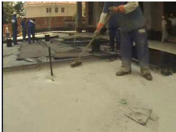
Figura 14. Área em processo de limpeza.
