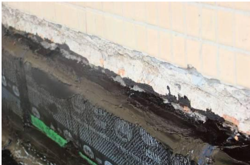
Figura 22. Detalhe do engastamento da manta na parede..
