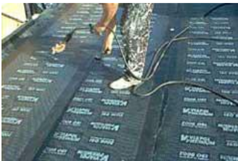
Figura 17. Imprimação e colagem de manta. – Fonte : CONSLAN
