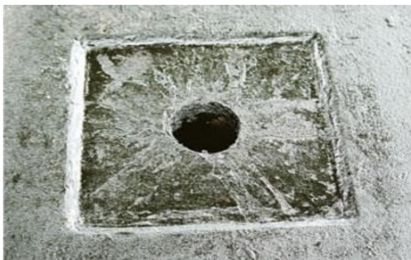
Figura 21. Detalhe de arremate do ralo concluído.
