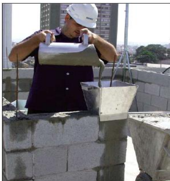
Figura 11 - Bloco de concreto sendo grauteado (FREITAS JUNIOR, 2012)
