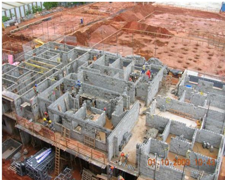
Figura 5 - Vista Superior de um edifício em Alvenaria Estrutural (ACERVO PRONTOMIX, 2009)
