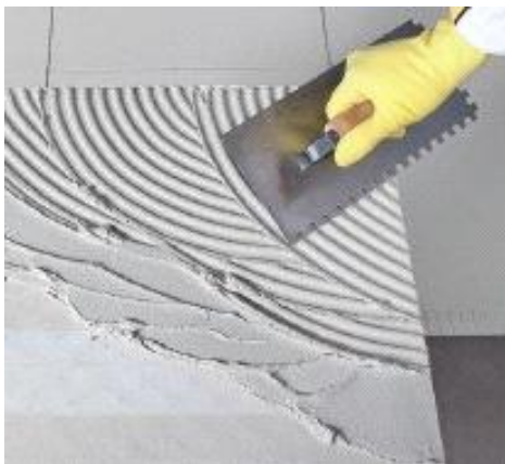
Figura 15 - Aplicação de Argamassa (WEBER, 2012)
