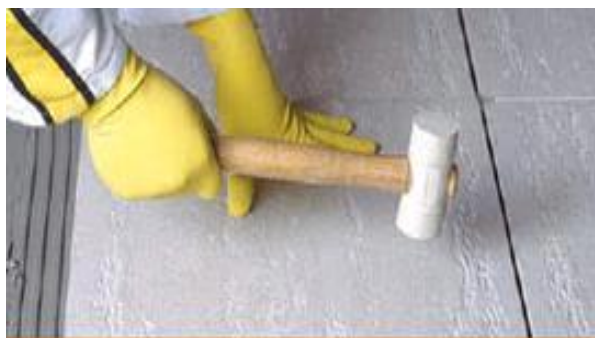
Figura 17 - Assentamento revestimento (WEBER, 2012)
