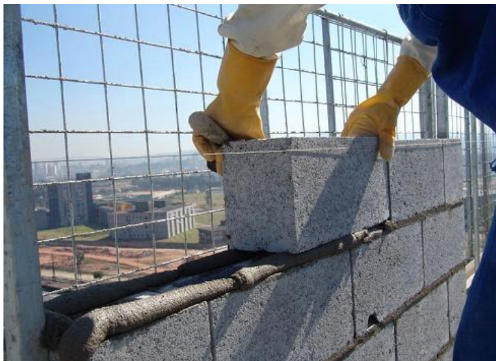
Figura 10 - Assentamento de alvenaria estrutural. (CONSTRUFACILRJ, 2012)
