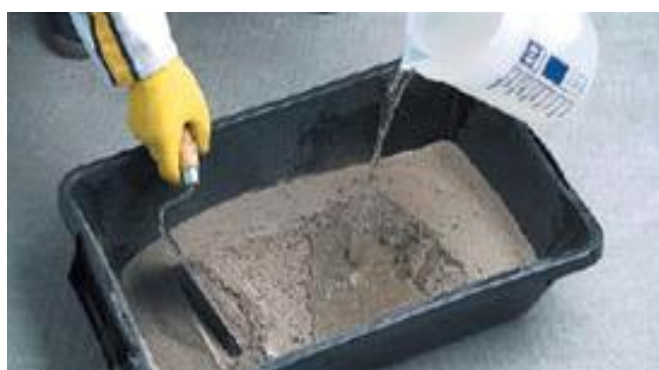
Figura 14 - Preparação Argamassa (WEBER, 2012)
