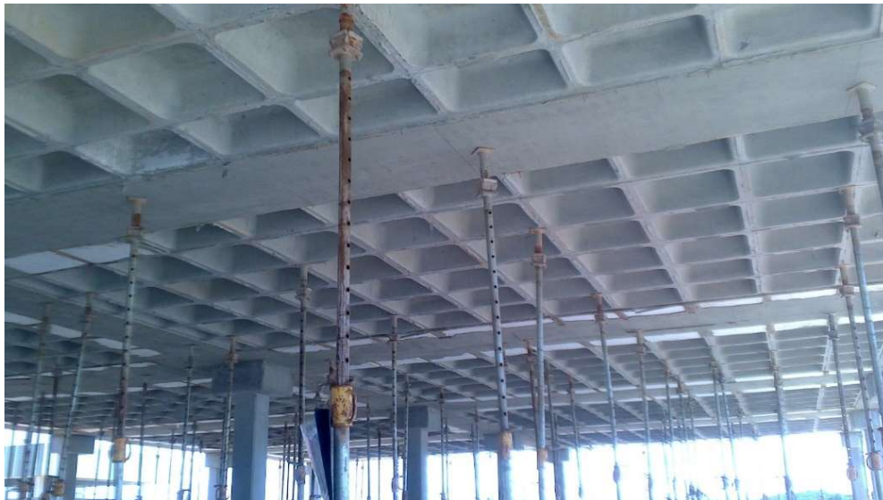
Figura 8 – Exemplo de laje nervurada executada com formas plásticas após desforma e com escoramento após 14 dias da concretagem.
