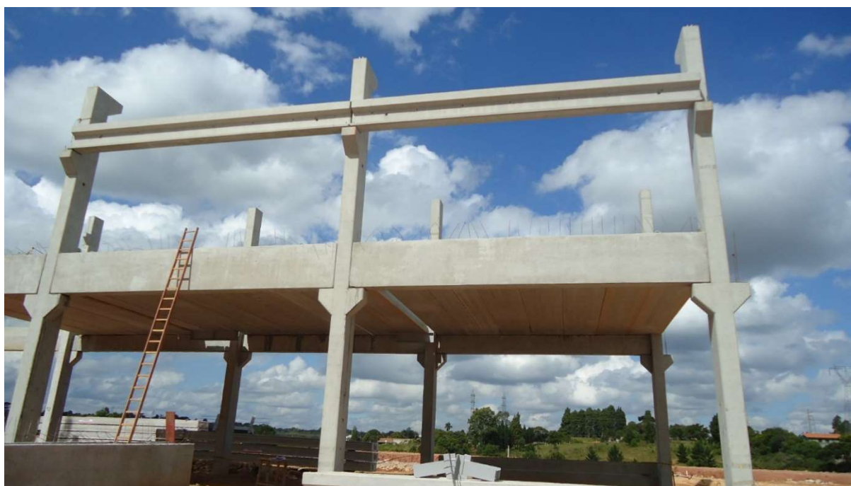
Figura 6 – Laje alveolar montada e peças armazenadas ao fundo.
