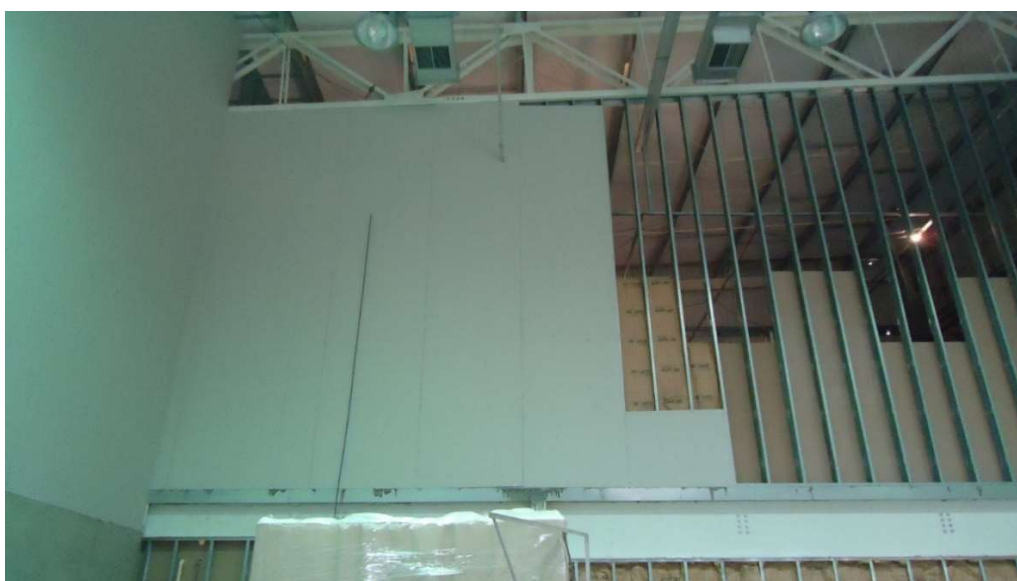
Figura 10 – Exemplo de parede em drywall já com montantes de estruturação e início do fechamento com chapas em uma das faces.
