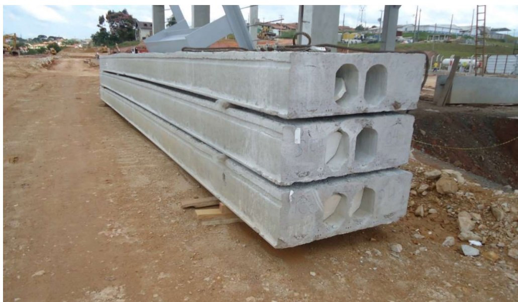
Figura 5 – Exemplo de lajes alveolares com alvéolos.
