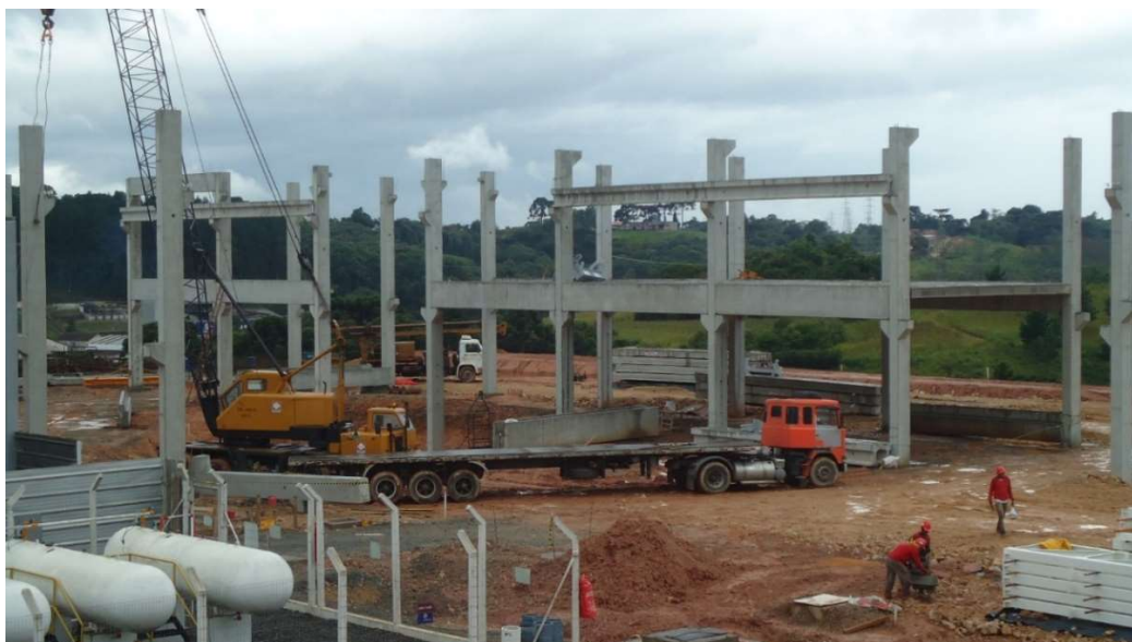
Figura 3 – Exemplo de estrutura de concreto pré-fabricada sendo montada com equipamento de grande porte (guindaste).
