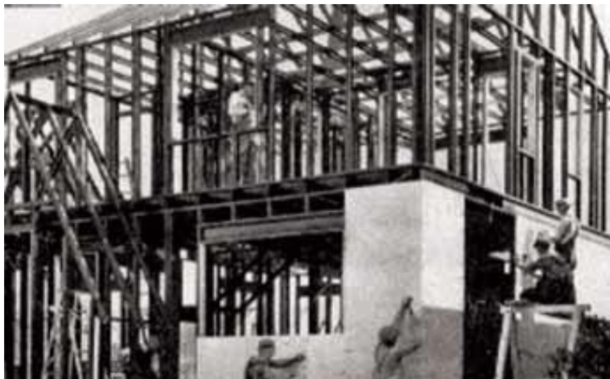
Figura 6: Primeira construção em LSF.
