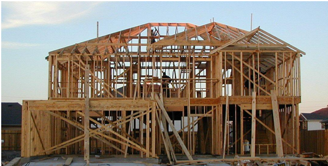
Figura 1: Sistema construtivo wood frame .
