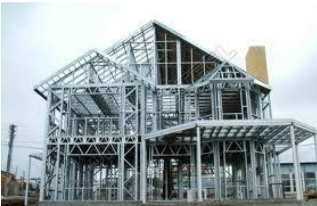
Figura 5: Estrutura executada no sistema Steel Frame , para posterior fechamento.
