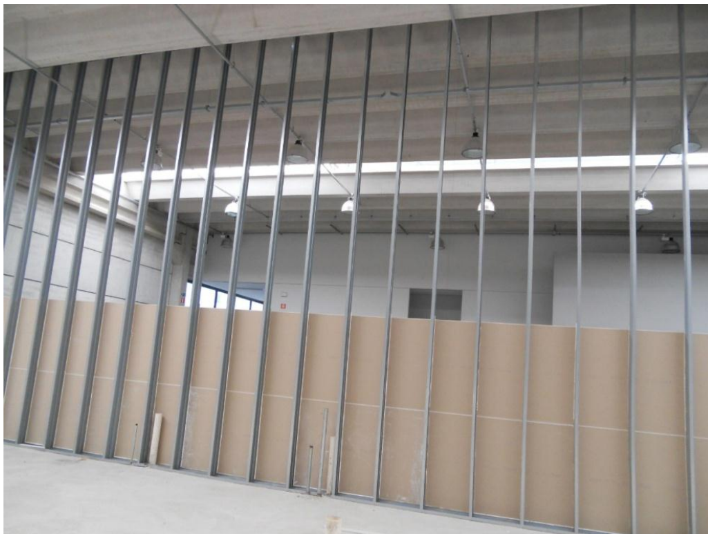
Figura 8: Estrutura para fechamento em gesso acartonado.
