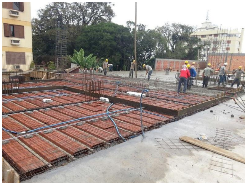
Figura 15: Sistema Construtivo, laje nervurada (arquivo pessoal).
