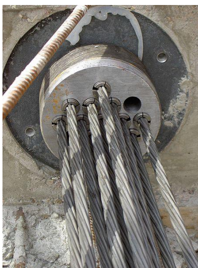
Figura 03: Fonte: Störfix. (2005), Stressing anchorage of Weidatalbridge.
