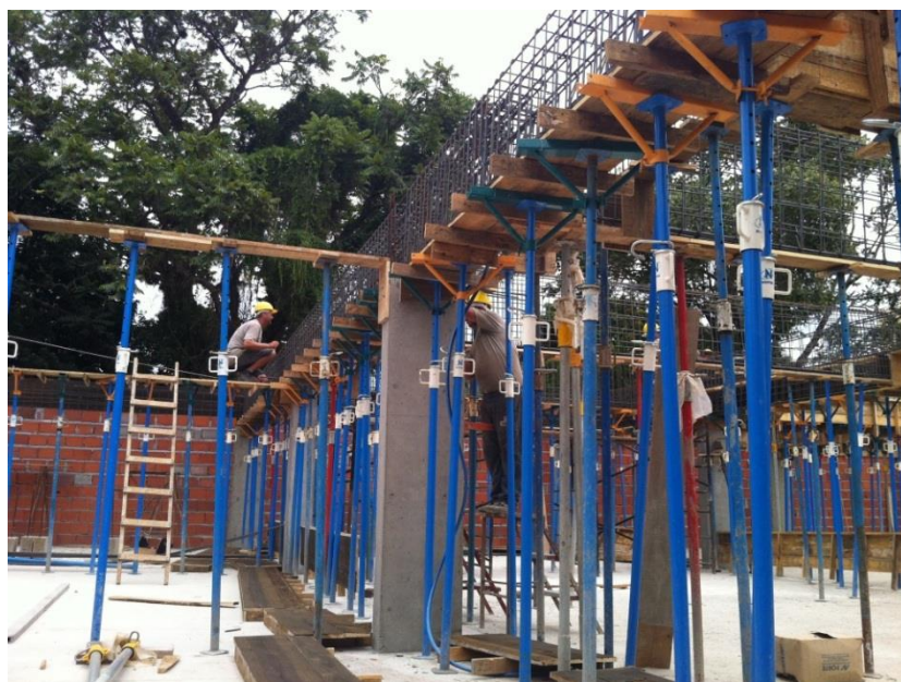
Figura 16: Escoramento Metálico (arquivo pessoal).
