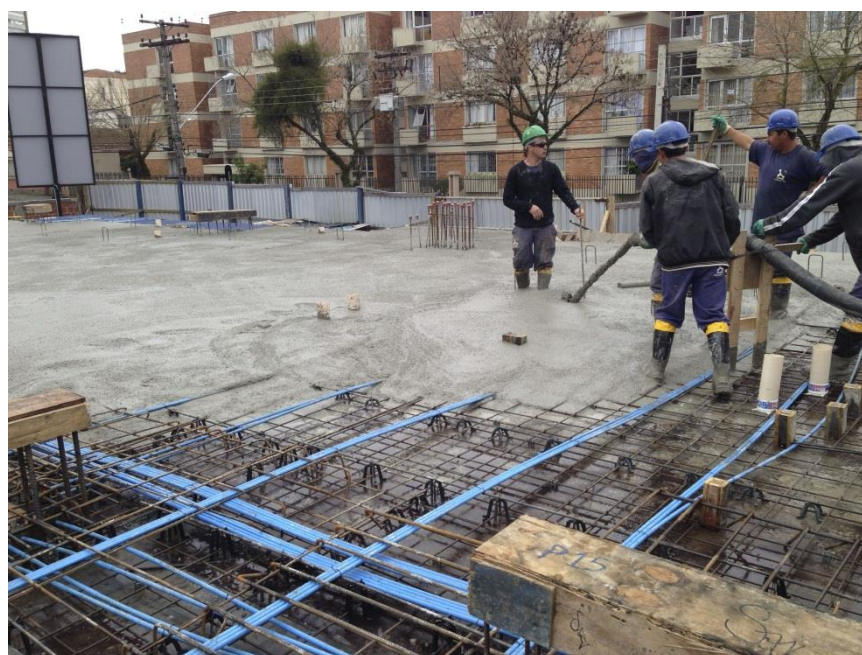
Figura 02: Concretagem com concreto auto adensável. Fonte: Edifício Alexandre Caron, 2013.
