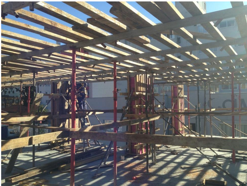
Figura 20: Escoramento Metálico (Arquivo pessoal).
