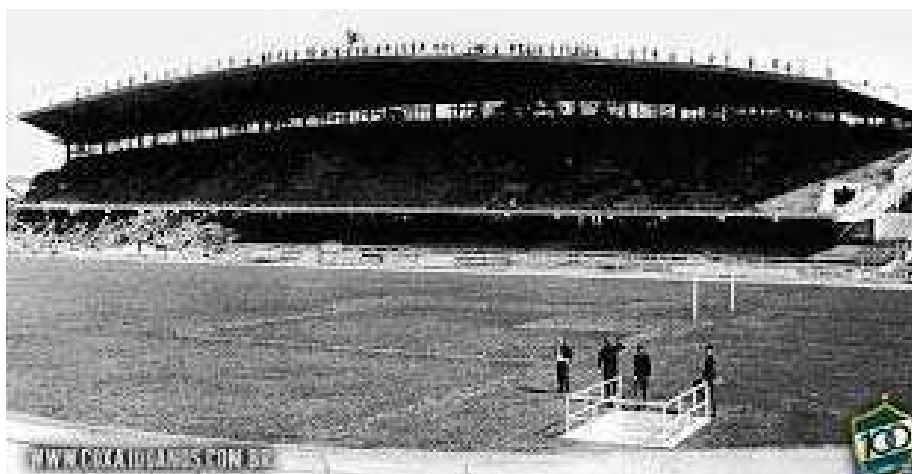
FIGURA 10. Prova de carga realizada por voluntários na marquise da social, 1969 (Fonte: Coritiba Foot Ball Club)
