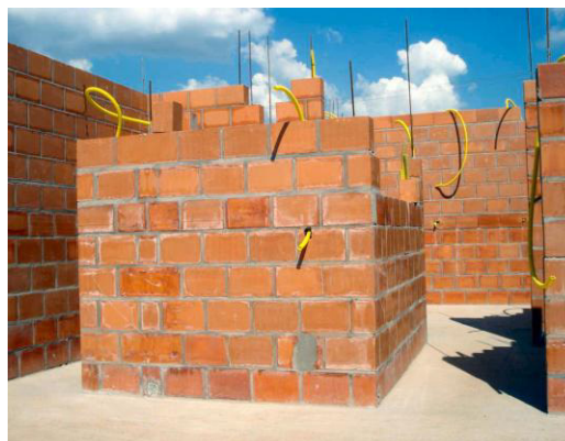
Figura 6. Alvenaria Convencional em Blocos Cerâmicos Fonte: http://www.revistatechne.com
