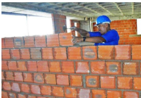
Figura 8. Execução de Alvenaria Convencional em Blocos Cerâmicos Fonte: http://www.revistatechne.com.br/
