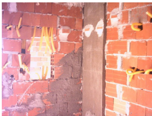
Figura 9. Execução de Alvenaria Convencional em Blocos Cerâmicos
