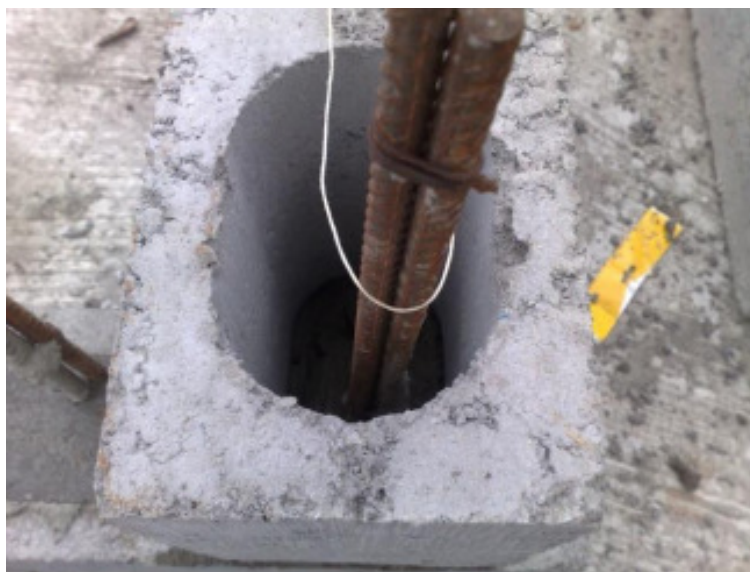
Figura 13. Barra de aço dentro do bloco limpo, esperando o grout Fonte: Arquivo próprio
