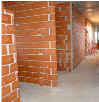
Figura 5. Alvenaria Convencional em Blocos Cerâmicos Fonte: http://www.revistatechne.com
