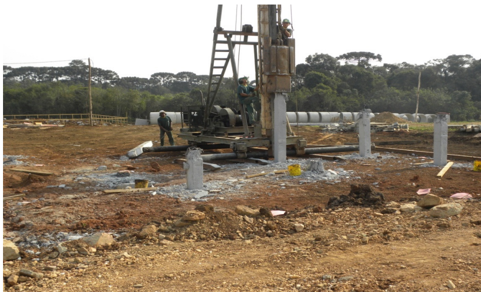
Figura 15 - Fundação no caso desta obra em cravação de estacas pré-moldadas.
