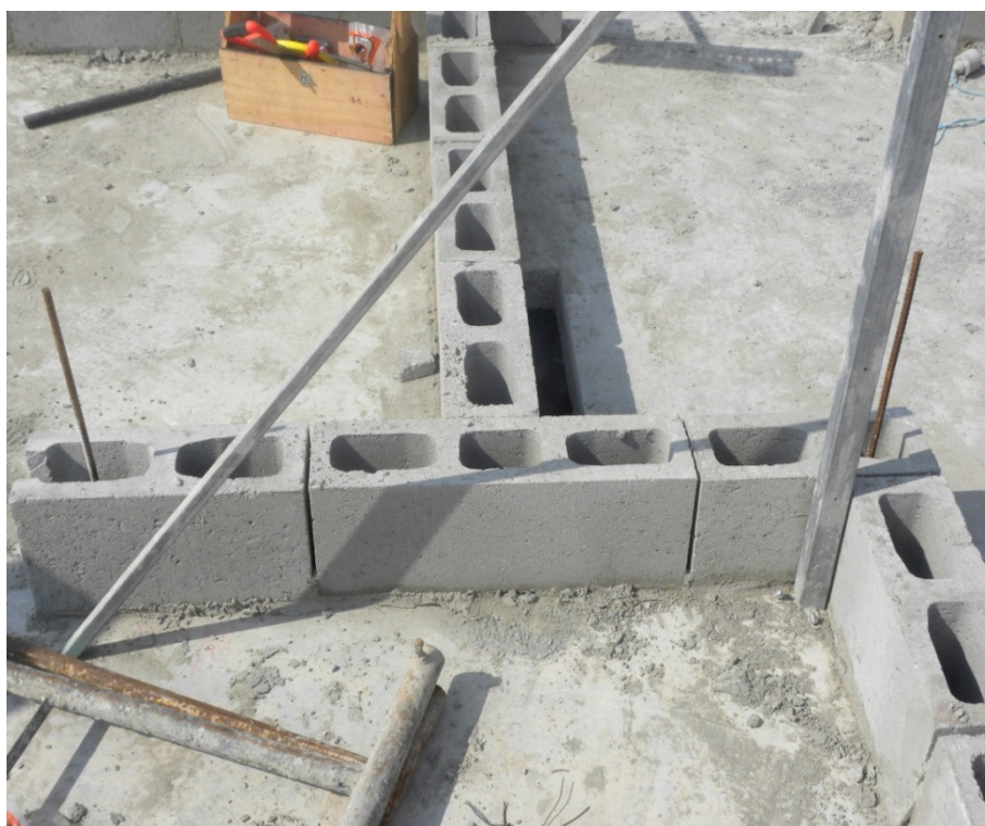
Figura 6 - Início da modulação horizontal, exatamente como prevê o projeto.
