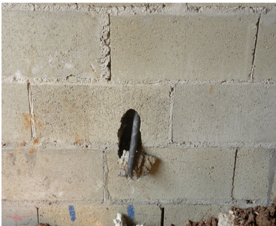
Figura 18 – Instalação para telefone.
