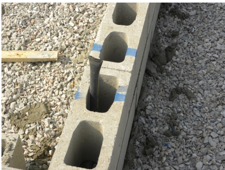
Figura 10 - Execução das primeiras fiadas, faixa azul indicando local para passagem de tubulação elétrica.
