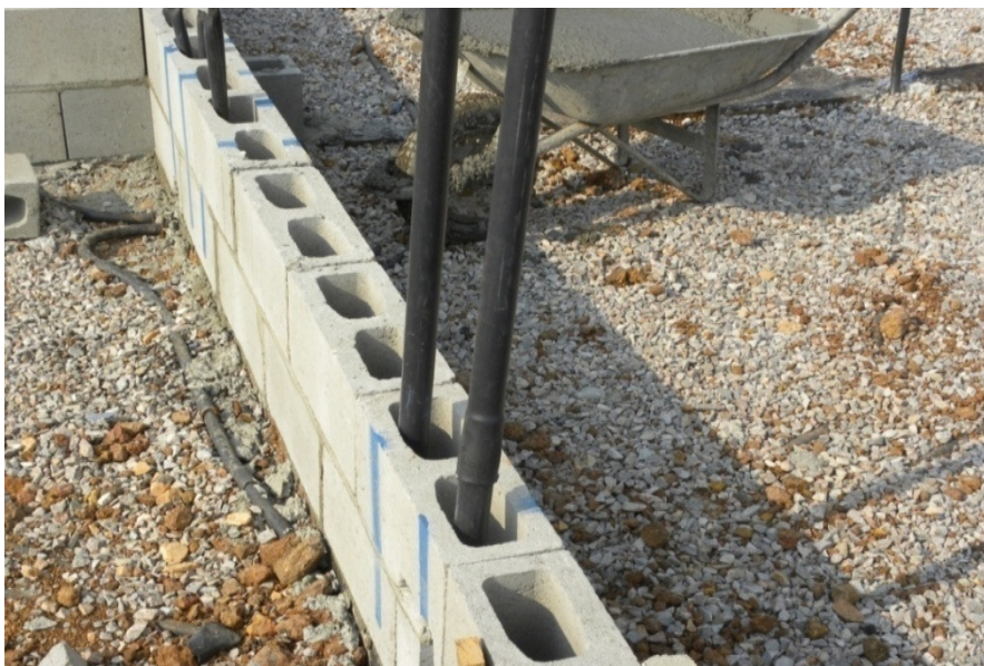
Figura 16 – Instalação elétrica faixas azuis indicando o local para passagem para não groutear.
