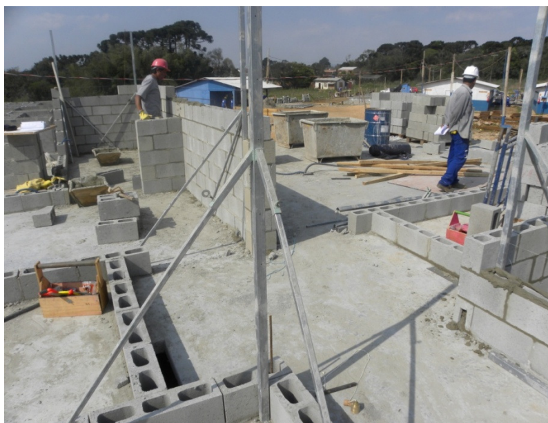
Figura 9 – Escantilhão, essencial para deixar as paredes perpendiculares.
