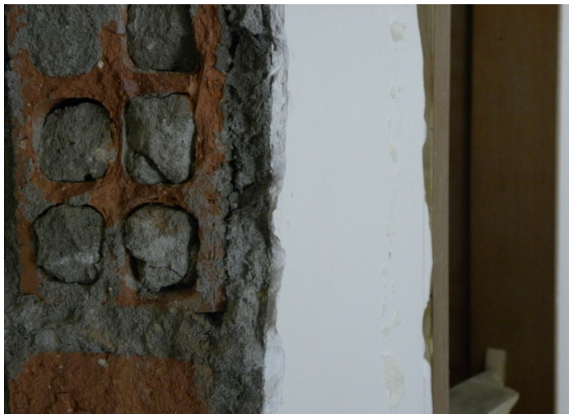
Figura 12 – Revestimento em reboco com 5 cm de espessura.
