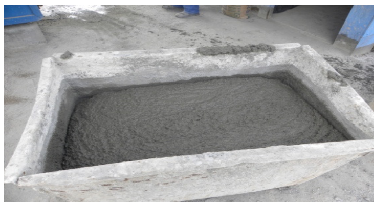
Figura 8 – O groute produzido in loco .
