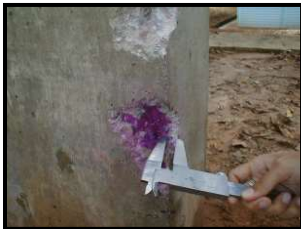
FIGURA 21. Medição da profundidade de carbonatação (Figueiredo, 2018)
