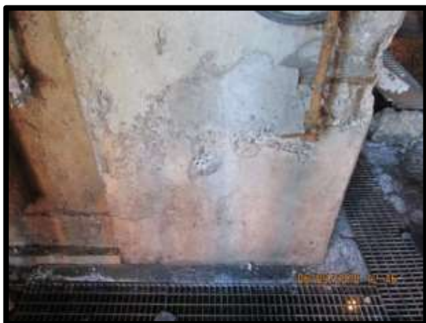
FIGURA 60. Pilar com segregação e alto índice de vazios
