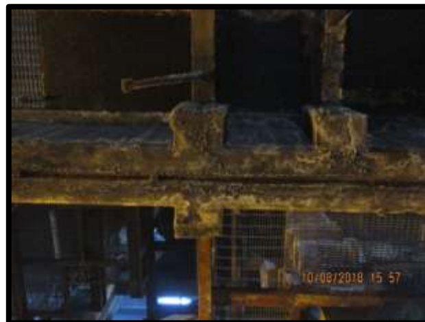
FIGURA 49. Viga impregnada com fuligem gerada no processo de produção
