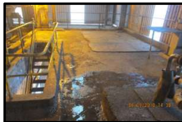
FIGURA 63. Laje sem sistema de proteção com derramamento de líquidos
