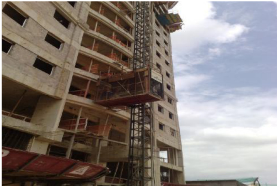
Figura 13 – Elevador de Cremalheira em obra em Belém-PA Fonte: http://www.markoengenharia.com.br/riodasflores.php
