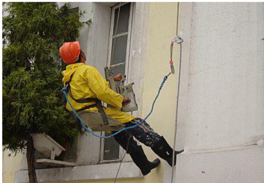
Figura 17 – Operário sendo sustentado por um balancim individual
