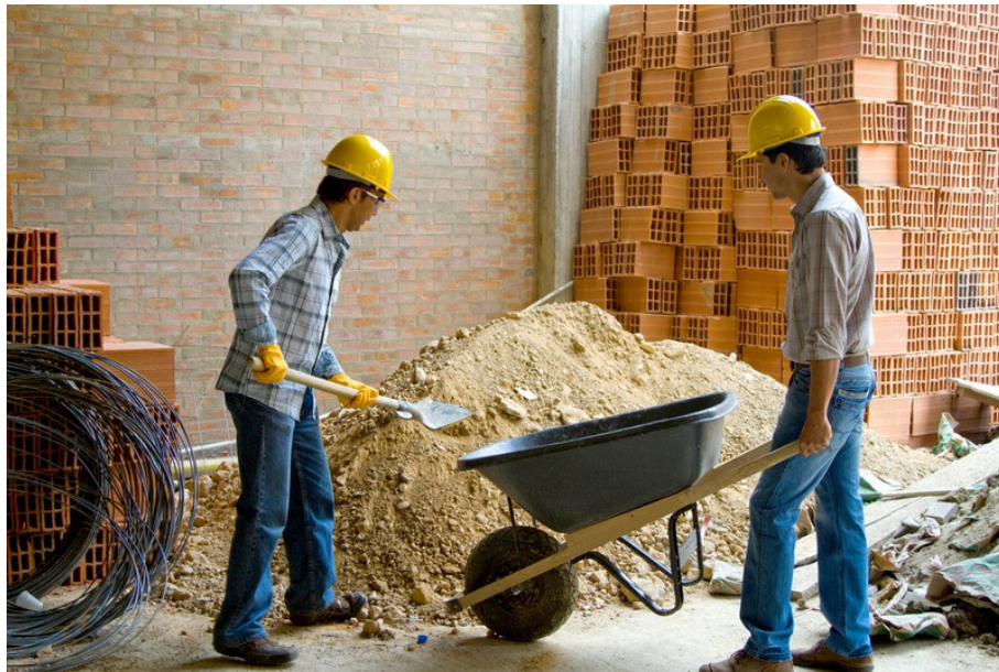
Figura 4 - o uso do carrinho de mão na obra
