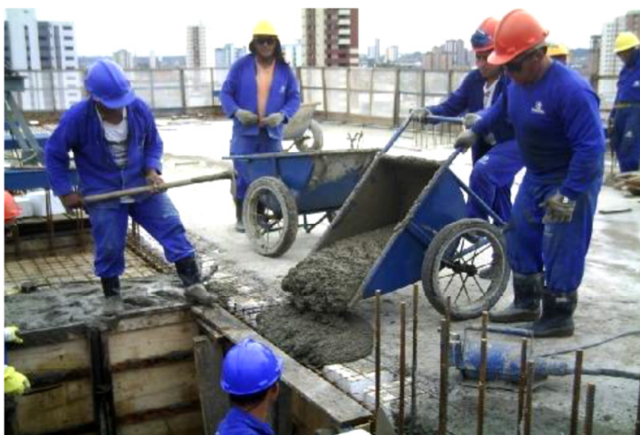
Figura 8 - Uso da jericica em obra de concretagem Fonte - http://www.markoengenharia.com.br/riodasflores.php
