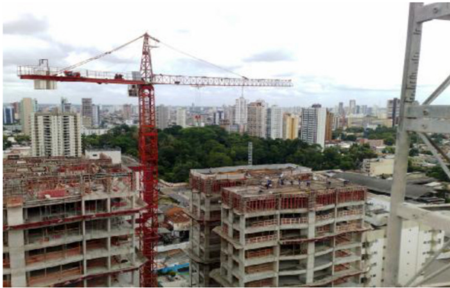
Figura 14 – Grua de lança giratória em obra - Belém-PA Fonte: http://www.markoengenharia.com.br/riodasflores.php
