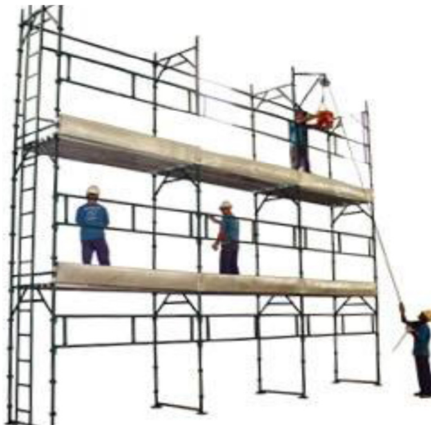
Figura 16- Ilustração com a aplicação do andaime fachadeiro em obra
