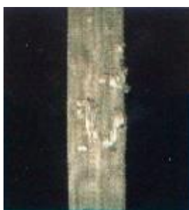
Danos longitudinais nas fibras.
