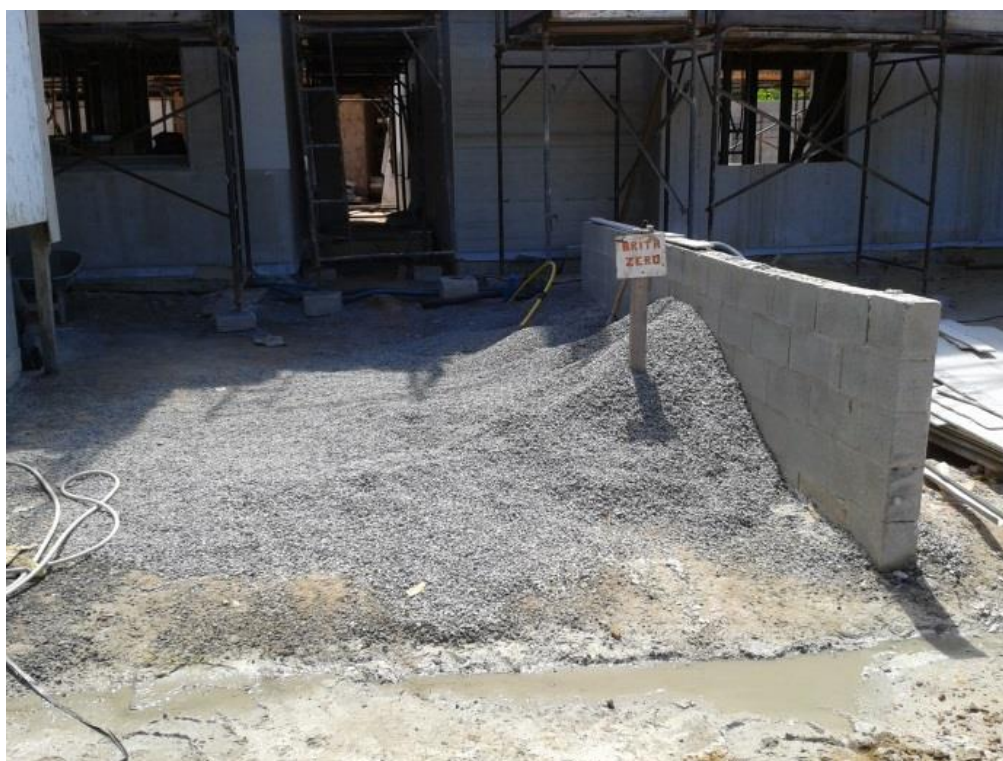
Foto 50 – Baia de brita sem fundo.
