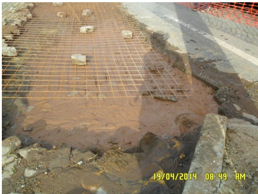
Figura 10 – Tela colocada irregularmente e a presença de “lama”
