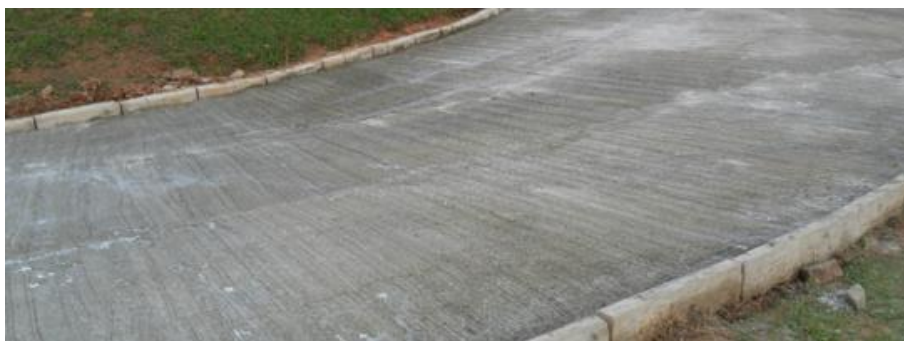
Figura 12 – Pavimento com a cura química no dia seguinte à concretagem
