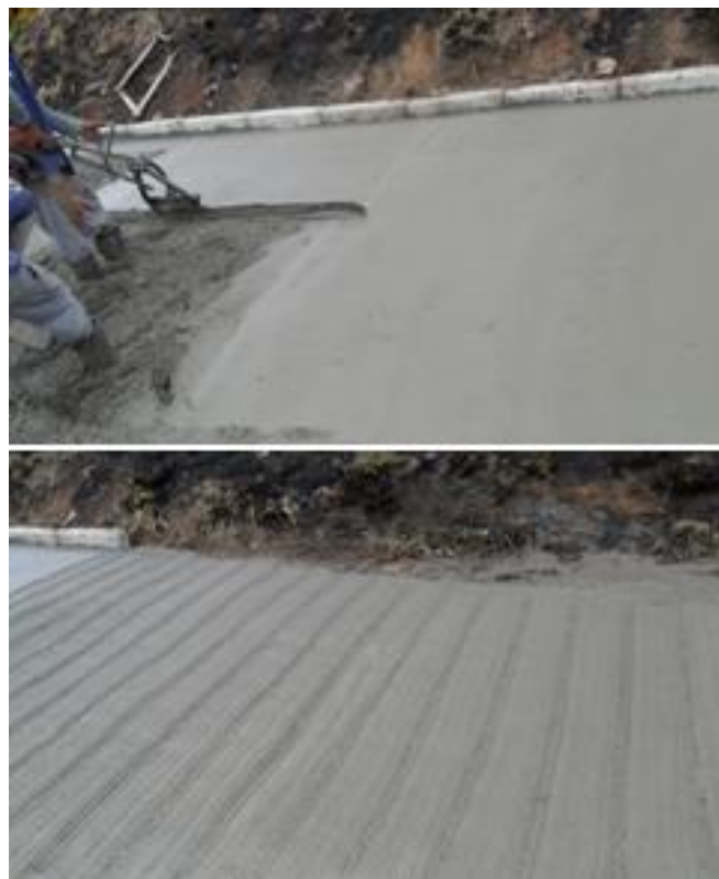
Figura 11 – Uso da régua vibratória e sarrafeamento
