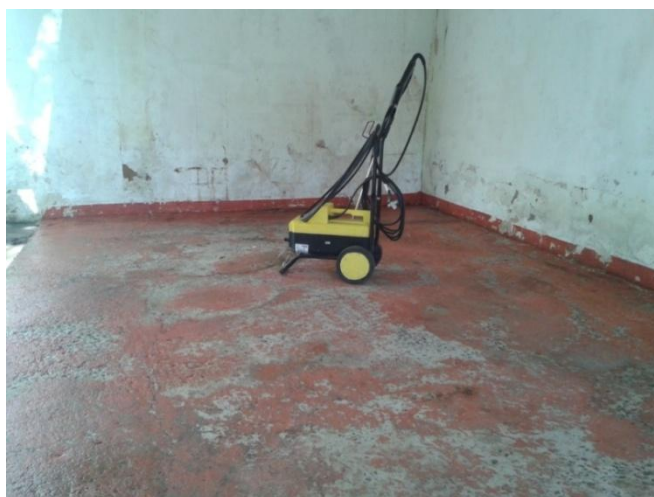
Figura 11 – Lavagem da base.
