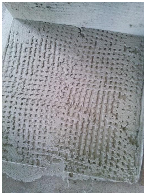
Figura 33 – Argamassa colante aplicada no contrapiso e no tardoz sem cruzamento dos cordões após arrancamento (amostra 2).
