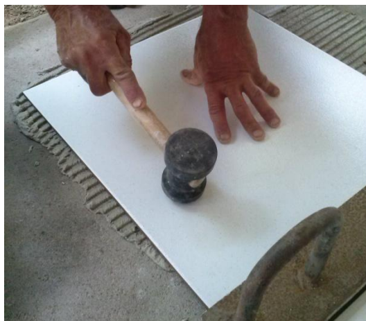
Figura 30 – Aplicação de vibração na placa cerâmica (amostra 3).
