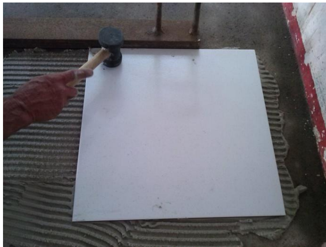
Figura 21 – Aplicação de vibração na placa cerâmica (amostra 1).
