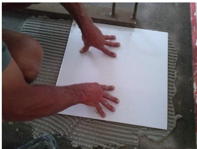
Figura 20 – Placa assentada fora da posição final (amostra 1).
