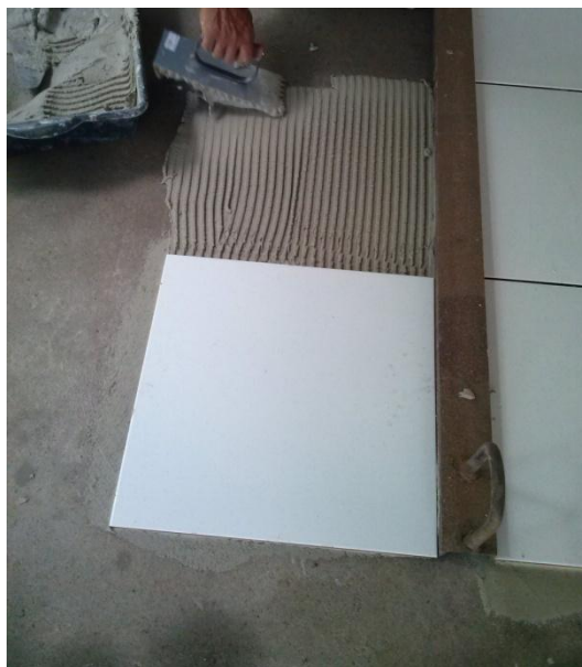
Figura 23 – Argamassa colante aplicada no contrapiso (amostra 2).
