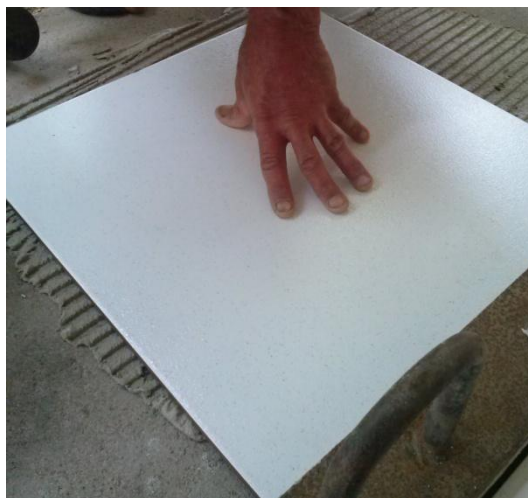
Figura 29 – Placa assentada na posição final (amostra 3).
