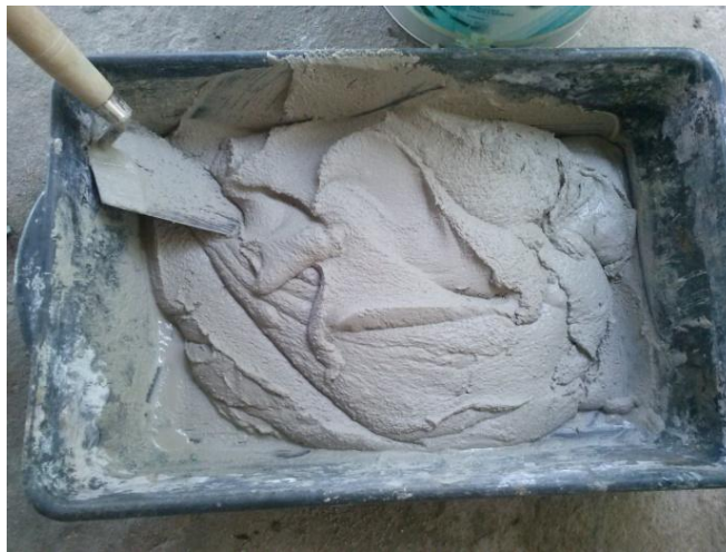
Figura 16 – Argamassa colante em repouso.
