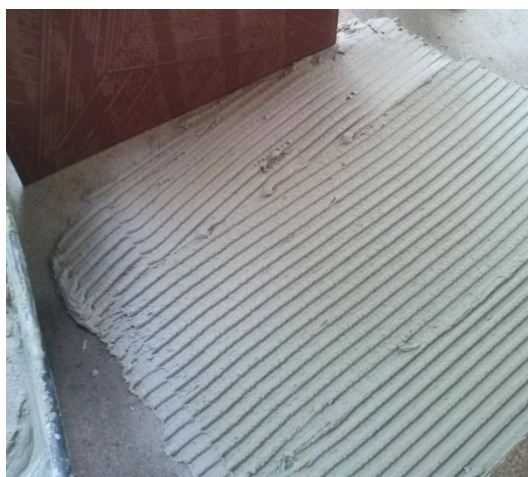
Figura 28 – Aplicação da argamassa colante no contrapiso (amostra 3).
