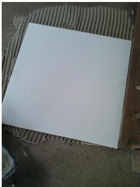
Figura 25 – Placa assentada na posição final (amostra 2).
