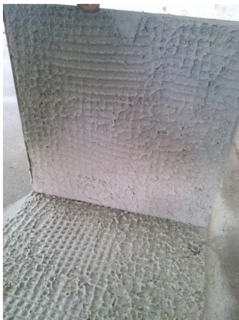
Figura 32 – Argamassa colante aplicada no contrapiso e no tradoz com cruzamento dos cordões após arrancamento (amostra 1).
