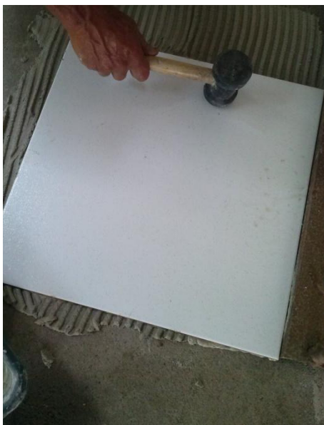
Figura 26 – Aplicação de vibração com martelo de borracha (amostra 2).
