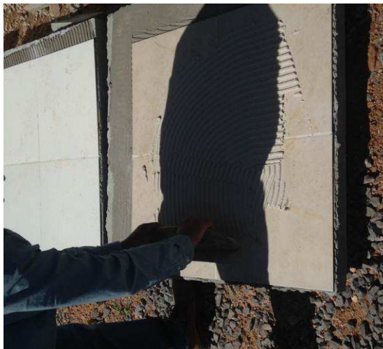
FIGURA 5-12 – APLICAÇÃO DA ARGAMASSA CAMADA 02.
