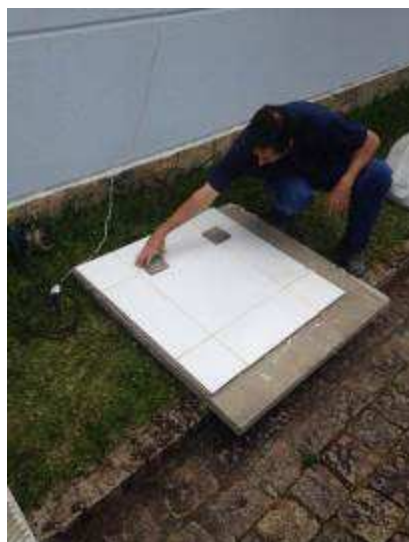
FIGURA 5-17 – MARCAÇÃO DOS PERÍMETROS DAS PLACAS METÁLICAS.
