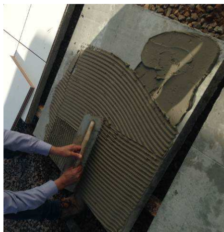
FIGURA 5-7 – APLICAÇÃO ARGAMASSA COLANTE CAMADA 01.
