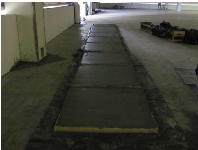
FIGURA 5-4- EXECUÇÃO SUBSTRATO.
