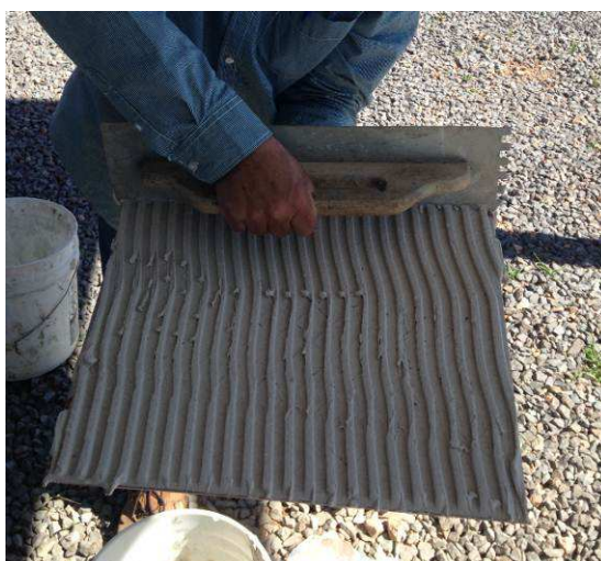
FIGURA 5-13 – APLICAÇÃO DA ARMAGASSA NO TARDOZ.
