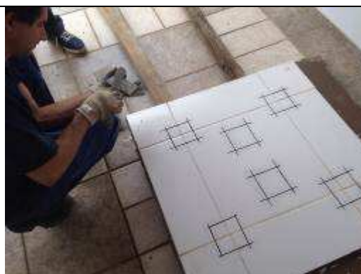
FIGURA 5-23 – APLICAÇÃO DA COLA
