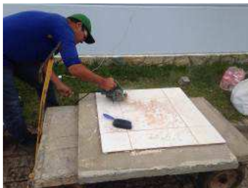
FIGURA 5-19 – CORTE MECANICO DO PERÍMETRO DEMARCADO.
