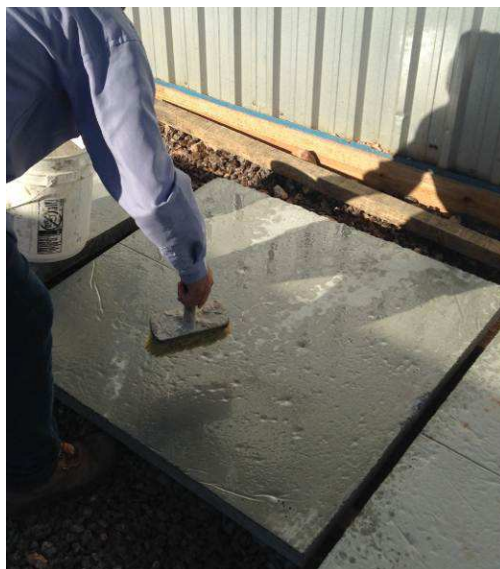
FIGURA 5-5 – ESPARGIMENTO DE ÁGUA.
