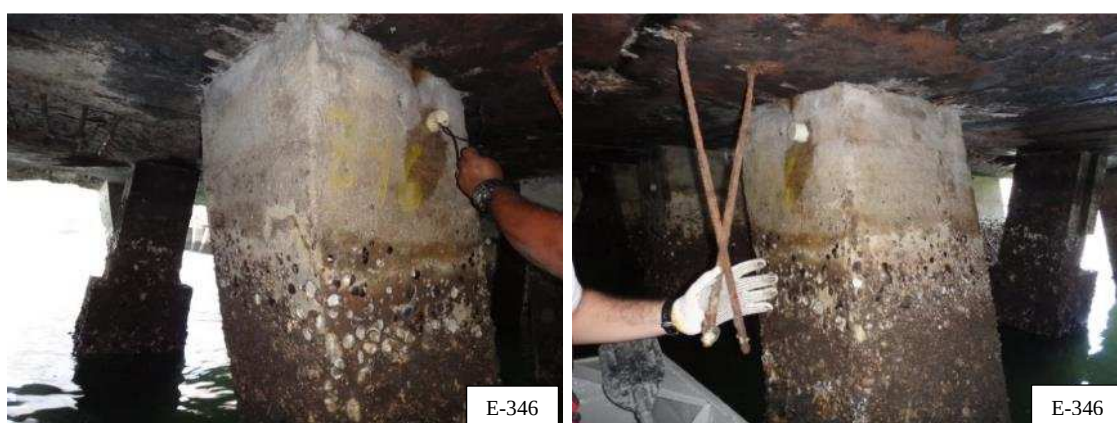
Figura 34 – Vista geral da estaca E-346, sem anomalias aparentes (Acervo pessoal, 2014).
