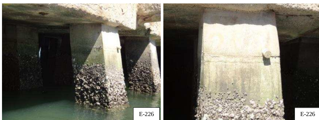
Figura 32 – Vista geral da estaca E-226, sem anomalias aparentes (Acervo pessoal, 2014).
