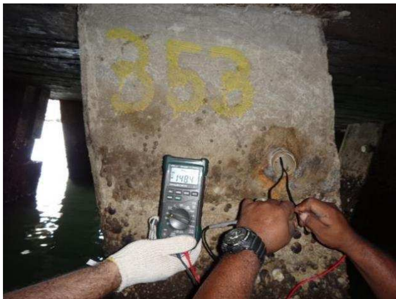
Figura 24 – Detalhe da medição da corrente na estaca E-353 (Acervo pessoal, 2014).
