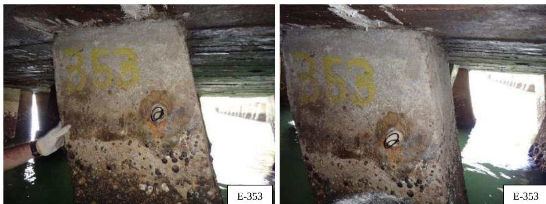
Figura 35 – Vista geral da estaca E-353, sem anomalias aparentes (Acervo pessoal, 2014).
