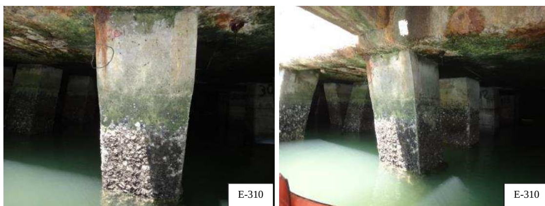
Figura 30 – Vista geral da estaca E-310, sem anomalias aparentes (Acervo pessoal, 2014).
