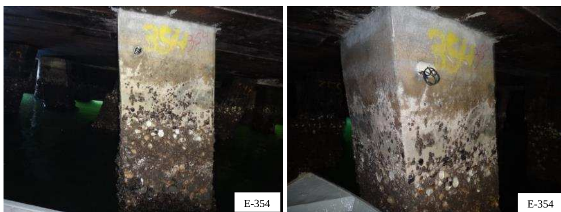
Figura 36 – Vista geral da estaca E-354, sem anomalias aparentes (Acervo pessoal, 2014).
