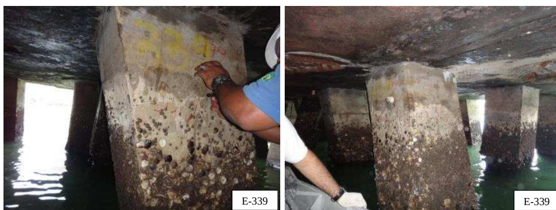
Figura 33 – Estaca E-339, sem anomalias aparentes (Acervo pessoal, 2014).
