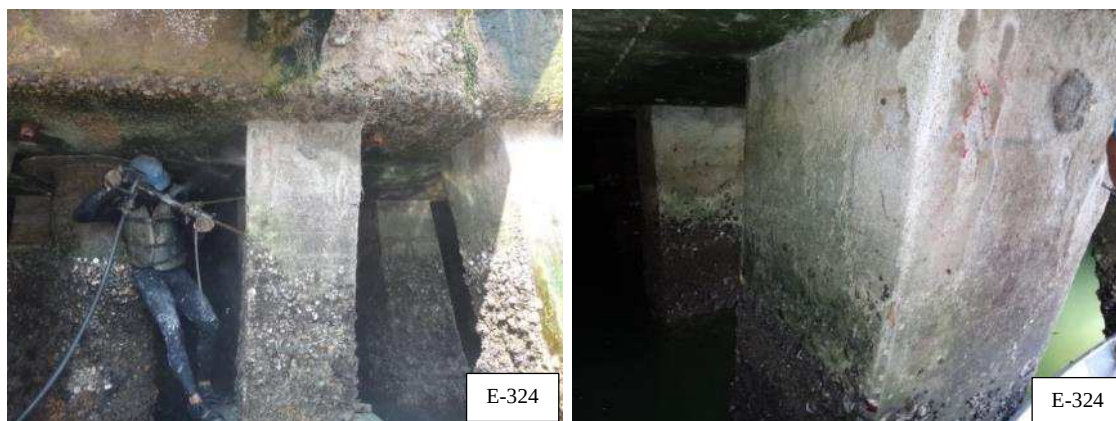
Figura 28 – Vista geral da estaca E-324, sem anomalias aparentes (Acervo pessoal, 2014).
