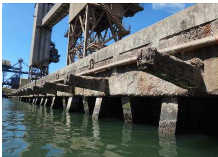
Figura 12 – Vista geral das estacas (Acervo Pessoal, 2014).
