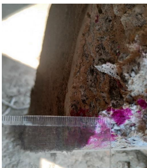
Figura 29 – Fotos ensaio de carbonatação n° 03 – Avaliação da frente carbonatada. Fonte: Autores
