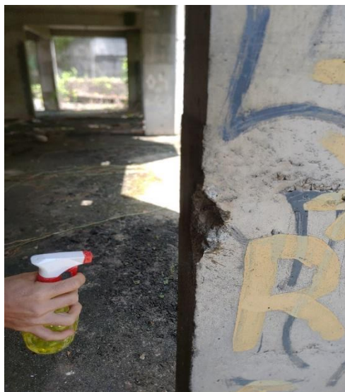
Figura 26 – Fotos ensaio de carbonatação n° 02 – Aspersão de fenolftaleína. Fonte: Autores
