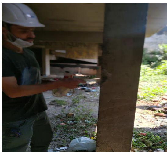
Figura 23 – Fotos ensaio de carbonatação n° 01 – Aspersão de fenolftaleína. Fonte: Autores
