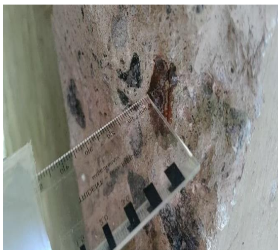
Figura 27 – Fotos ensaio de carbonatação n° 02 – Avaliação da frente carbonatada. Fonte: Autores
