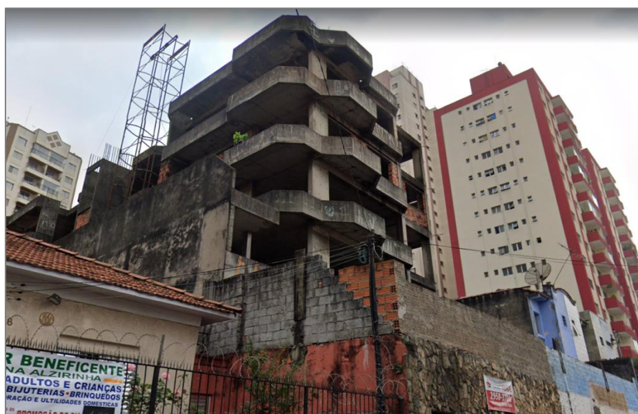
Figura 19 - Foto fachada edifício. Fonte: autores.
