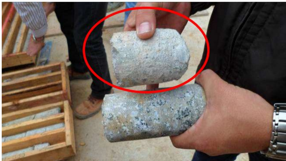
Figura 16 - Material Esbranquiçado no Concreto Estaca P-80
