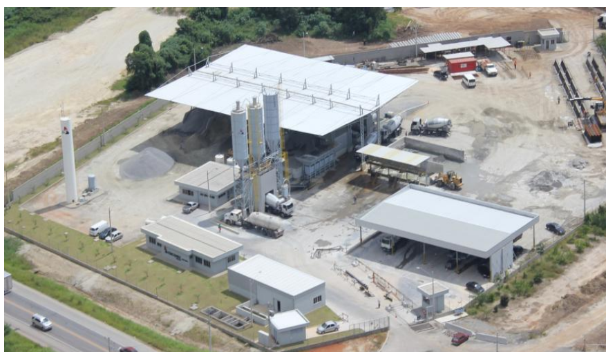
Figura 03 - Central dosadora de concreto utilizada.
