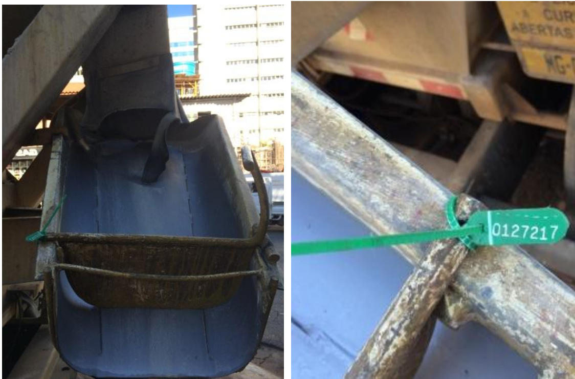
Fotos 1 e 2 – Recebimento do concreto e lacre do caminhão
