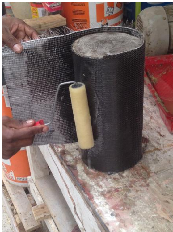
FOTO 17 - Aplicação da Segunda Camada de Fibra
