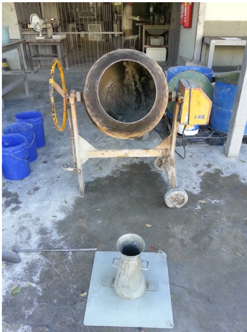
Figura 22. Moldagem de concreto in-loco.
