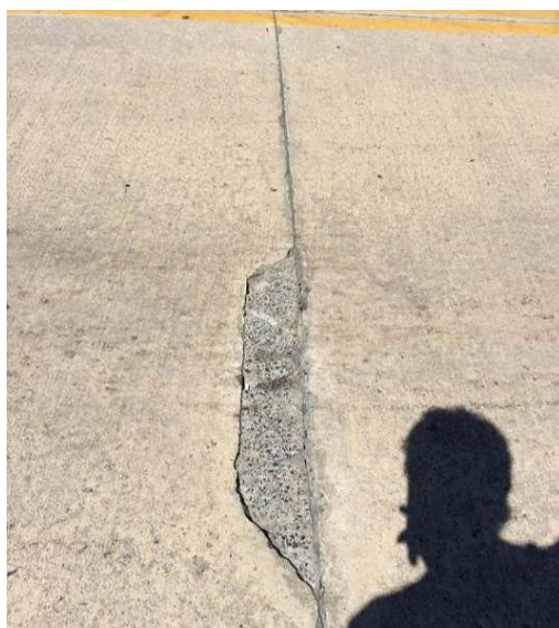
Foto 12 – Pequeno reparo na placa 21B
