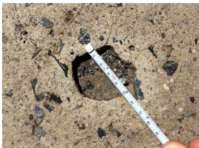
Foto 8 – Buraco de severidade baixa no pano 9B
