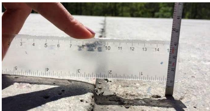
Foto 13 – Assentamento da placa 26A
