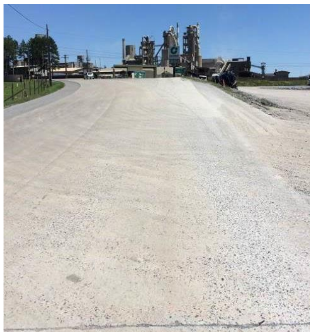
Foto 5 – Desgaste superficial próximo ao acesso da fábrica
