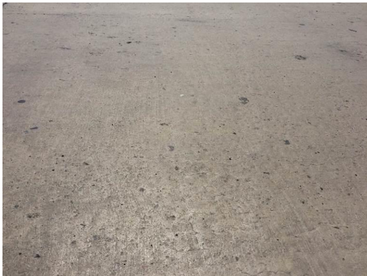
Foto 10 – Retração plástica na placa 15B
