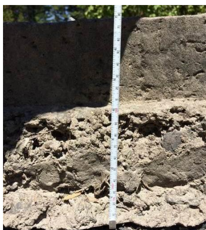
Foto 1 – Espessura do pavimento
