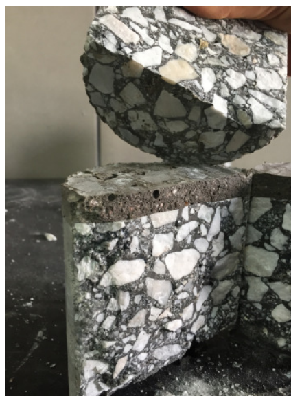
Figura 27- Aspecto de ruptura CLT
