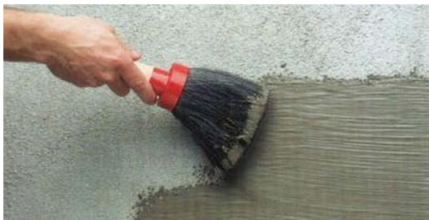
Figura 12. Aplicação de argamassa polimérica na forma de pintura (SAYEGH, 2001)
