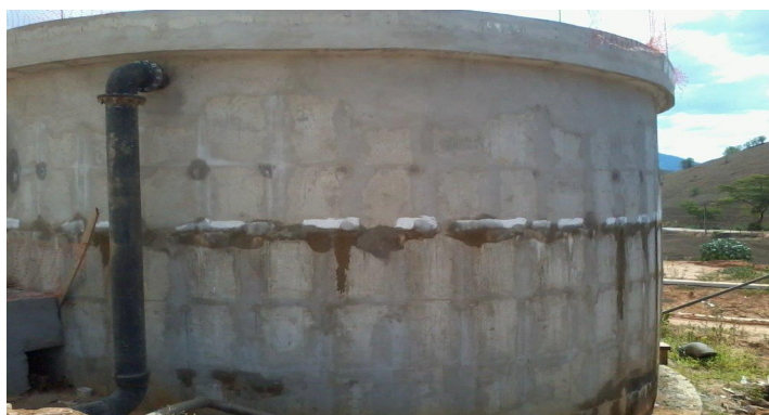
Figura 9. Teste de estanqueidade (ETA, 2014)
