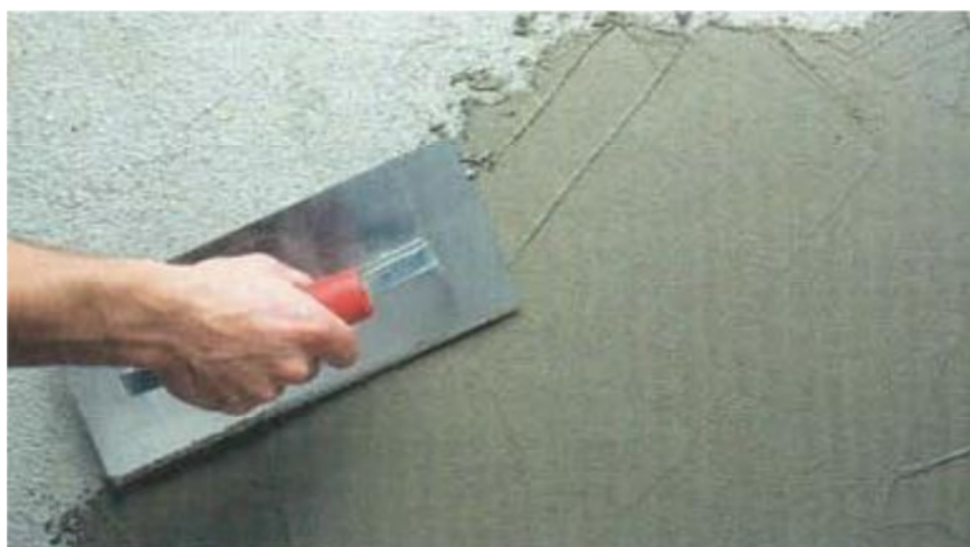
Figura 13. Aplicação de argamassa polimérica na forma de revestimento (SAYEGH, 2001)
