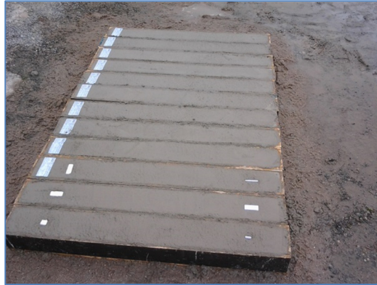
Foto 1 – Concretagem do Lote 01 com introdução das interferências.
