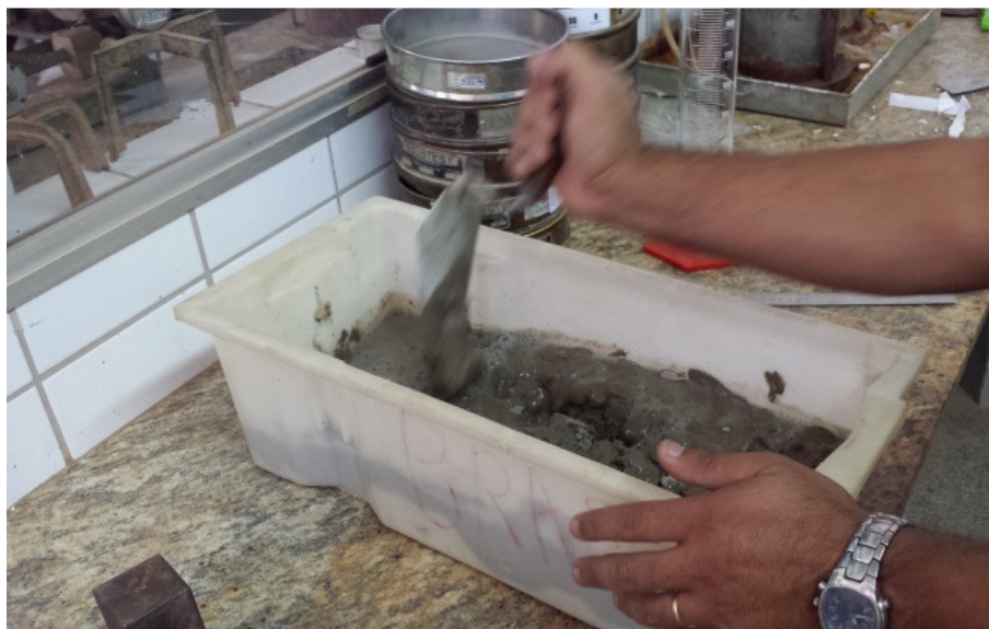
Figura 24. Mistura da argamassa.
