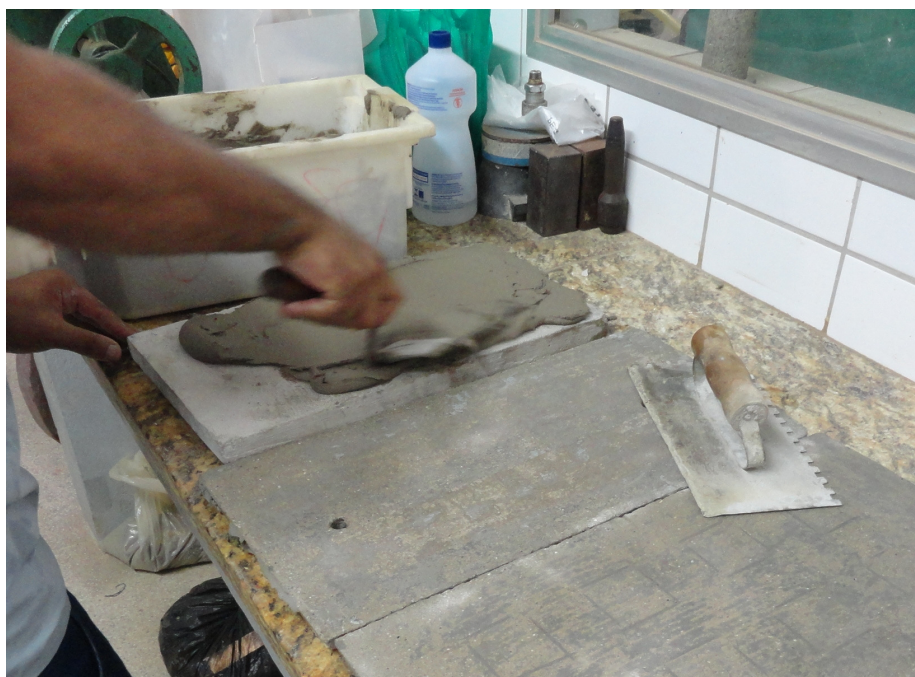
Figura 25. Aplicação da argamassa.
