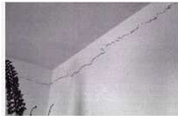
Figura 13 – Trinca típica no topo da parede paralela a laje (THOMAZ, 2003)
