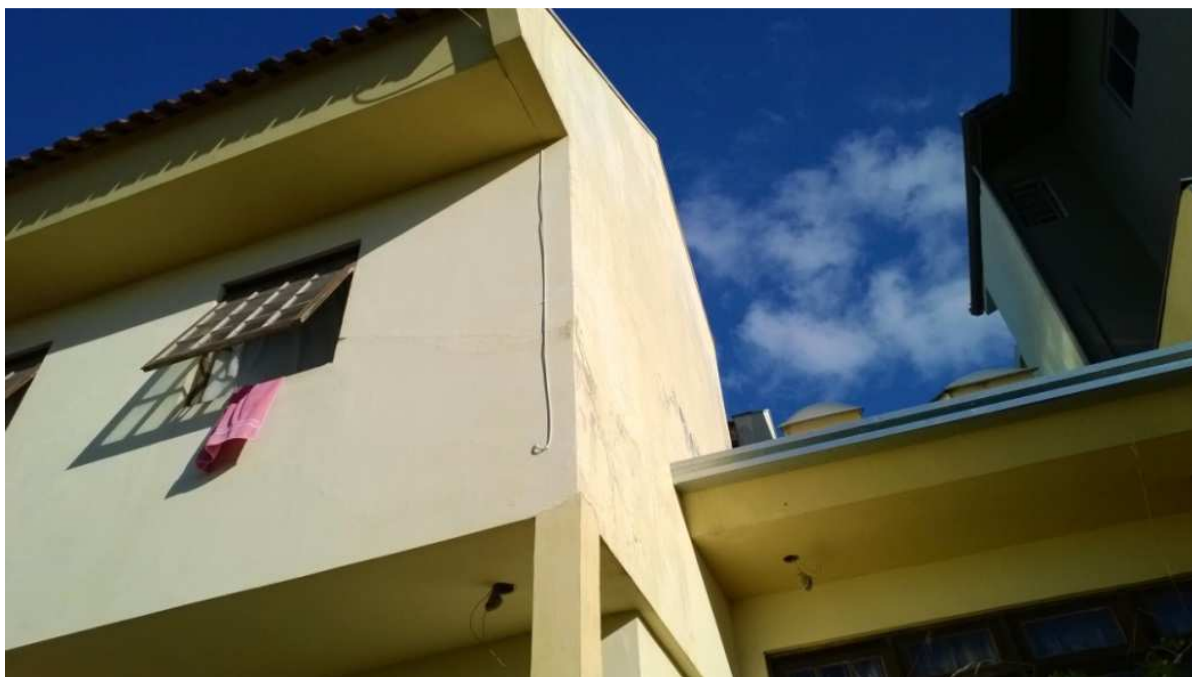
Figura 70– Vista externa do balanço com o pilar construído posteriormente
