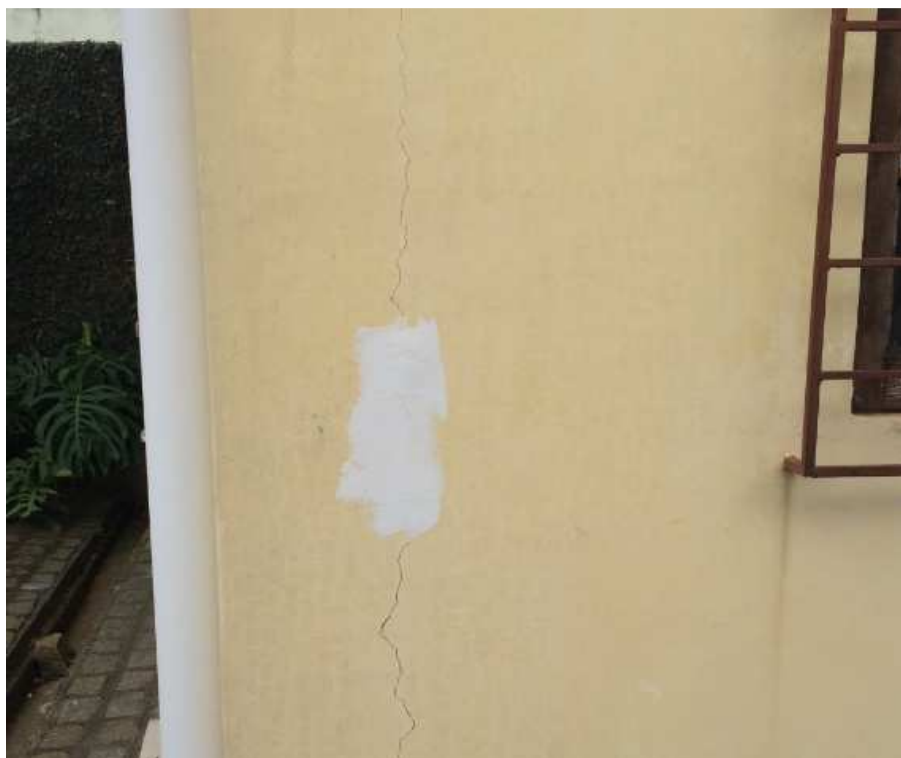
Figura 79– Espia de gesso colocada em ligação Pilar/Alvenaria
