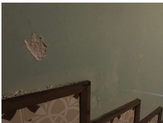
Foto 56 - Infiltração
