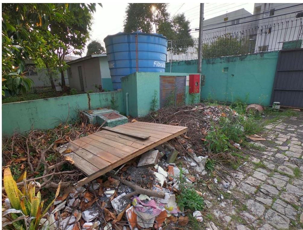
Foto 9 - Casa de bombas/Reservatório
