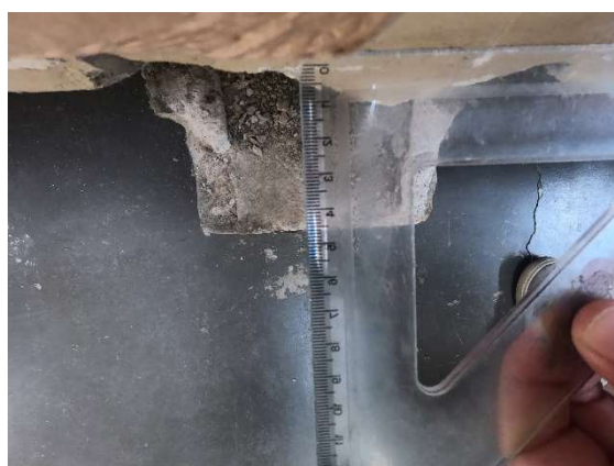
Foto 35 - Recalque de piso
