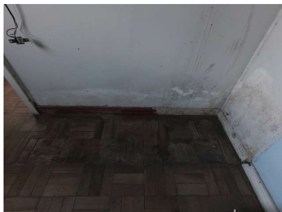
Foto 142 - Infiltração
