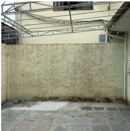
Foto 95 - Infiltração e Fissuração
