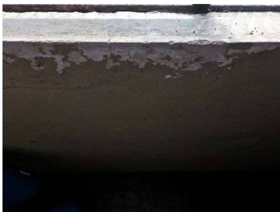
Foto 127 - Infiltração
