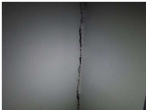
Foto 64 - Infiltração (Parede)
