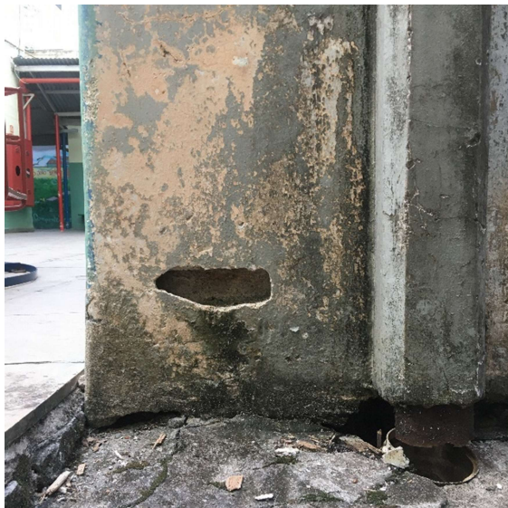
Foto 67 - Fissuração e Infiltração
