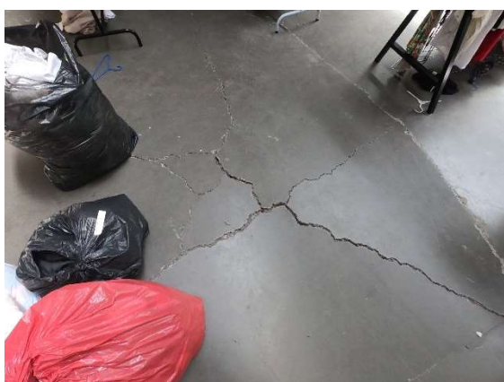
Foto 38 - Recalque de piso
