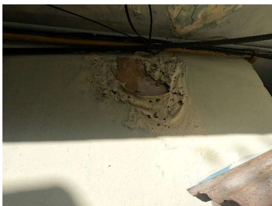
Foto 78 - Infiltração
