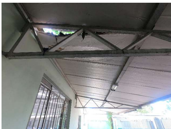
Foto 20 - Cobertura (Infiltração)
