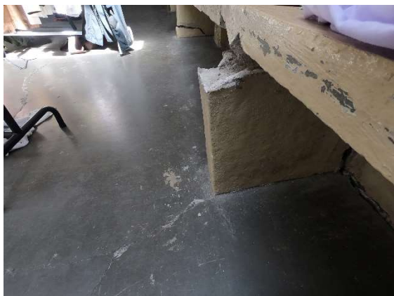
Foto 37 - Recalque de piso
