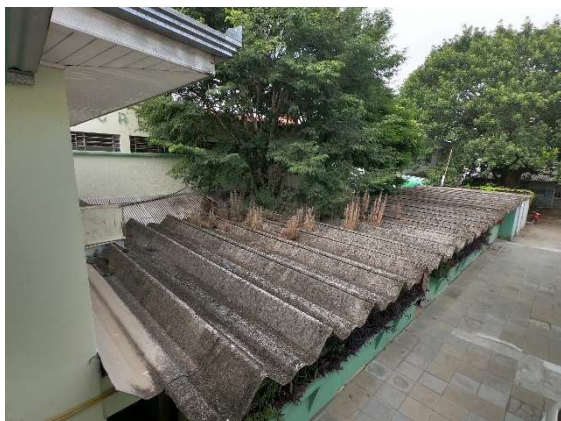
Foto 109 - Infiltração (Bicheira)
