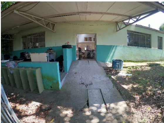
Foto 14 - Recalque + Infiltração
