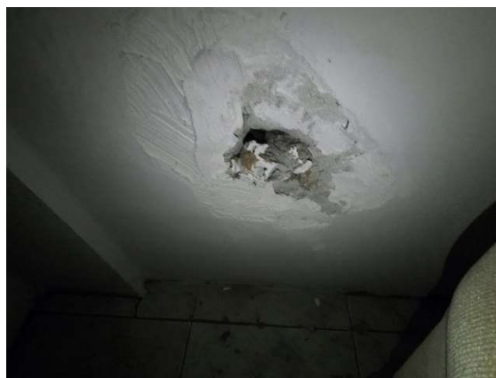
Foto 65 - Infiltração Teto
