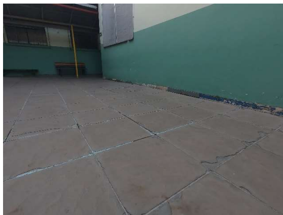
Foto 53 - Fissuração e Infiltração
