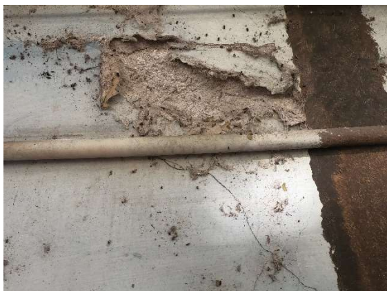
Foto 77 - Infiltração
