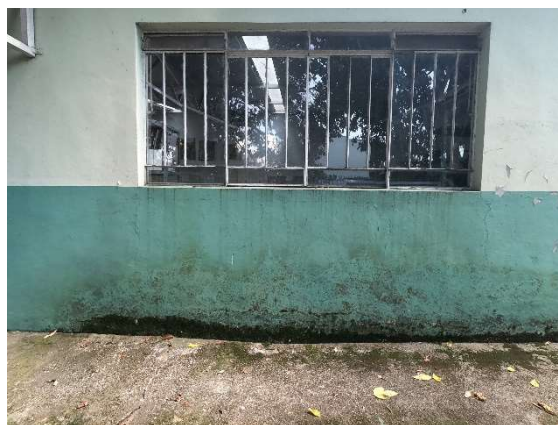
Foto 23 - Infiltração e fissuração
