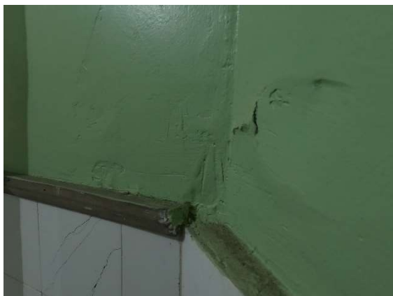
Foto 49 - Infiltração
