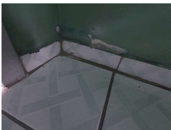
Foto 157 - Infiltração no rodapé
