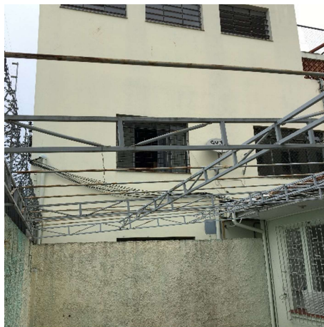
Foto 99 - Cobertura (Corrosão)
