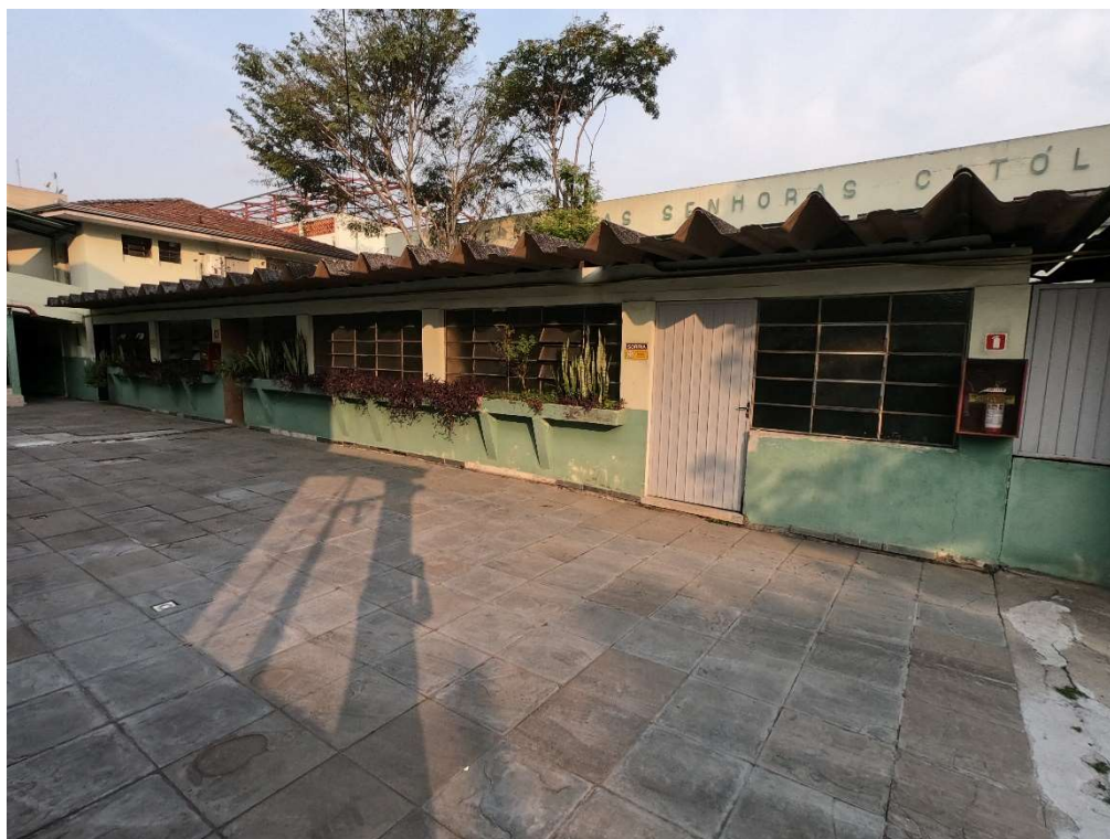
Foto 6 - Bloco 05 (WC Pátio)
