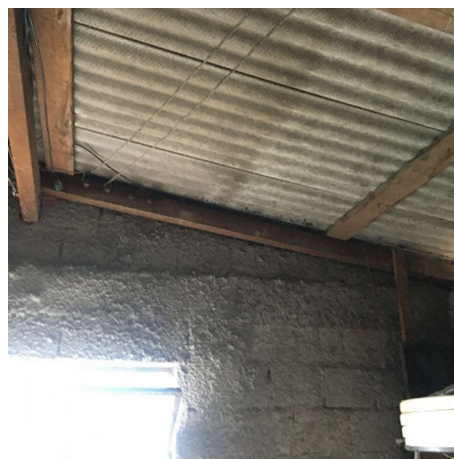
Foto 166 - Infiltração (Reservatório)
