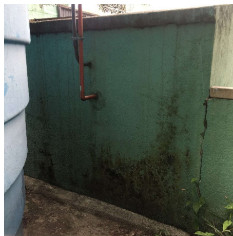
Foto 172 - infiltração (Bombas)
