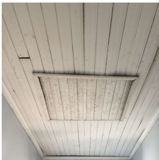
Foto 107 - Infiltração
