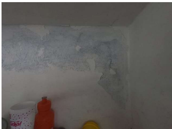
Foto 31 - Desplacamento (Argamasa)
