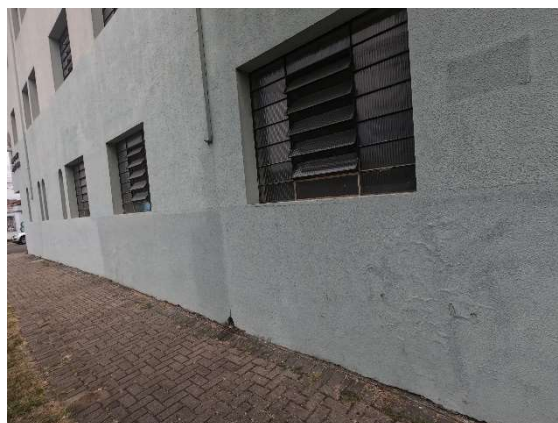
Foto 136 - Infiltração e Fissuração
