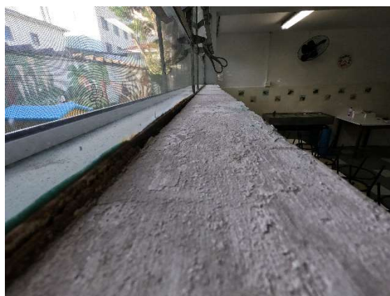
Foto 81 - Deterioração da pintura
