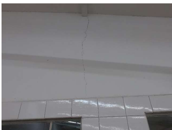
Foto 26 - Fissuração (Sobrepeso)
