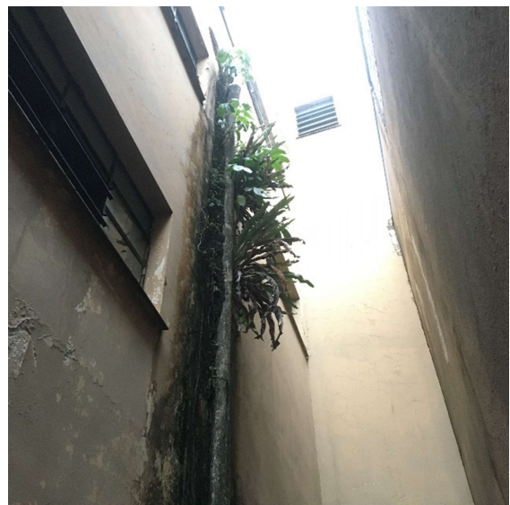
Foto 69 - Infiltração (Fachada)
