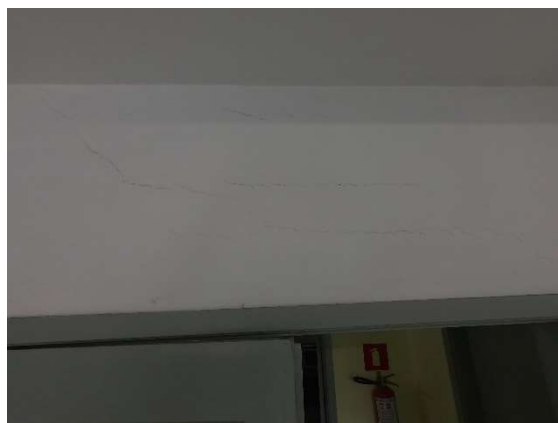
Foto 81 - Deterioração da pintura
