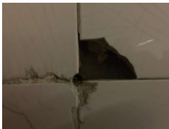
Foto 87 - Desplacamento e Som Cavo
