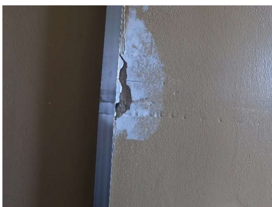
Foto 121 - Fissuração (Parede)
