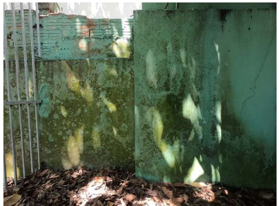
Foto 17 - Infiltração
