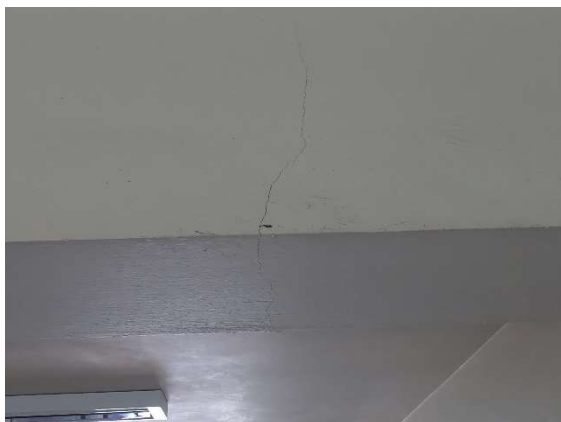
Foto 120 - Fissuração (Teto)
