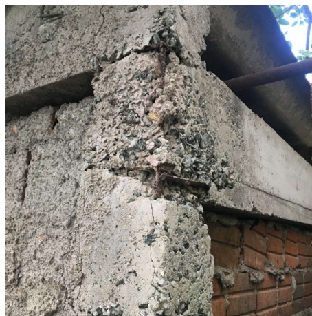
Foto 112 - Deslocamento / Corrosão
