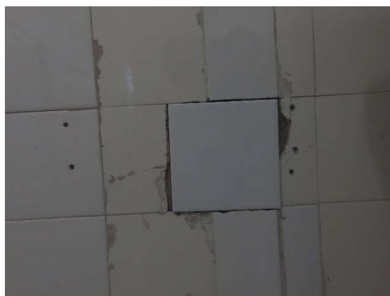
Foto 93 - Desplacamento e Som cavo
