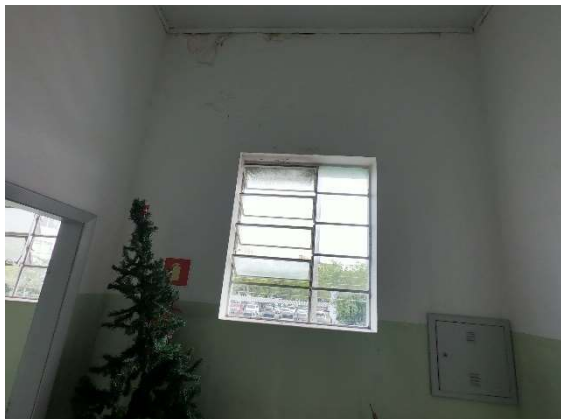
Foto 138 - Deterioração da pintura
