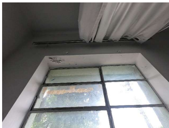
Foto 154 - Deterioração da pintura
