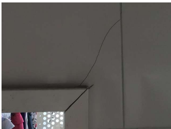
Foto 26 - Fissuração (Sobrepeso)
