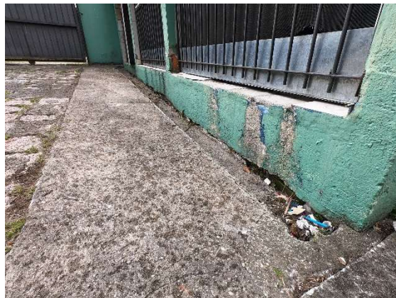
Foto 165 - Fissuração (Dep. Materiais)
