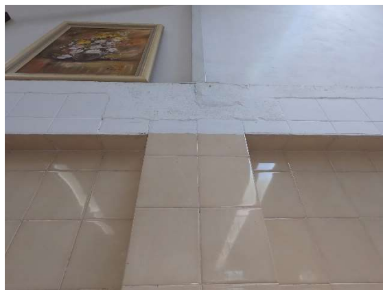
Foto 34 - Recalque de piso
