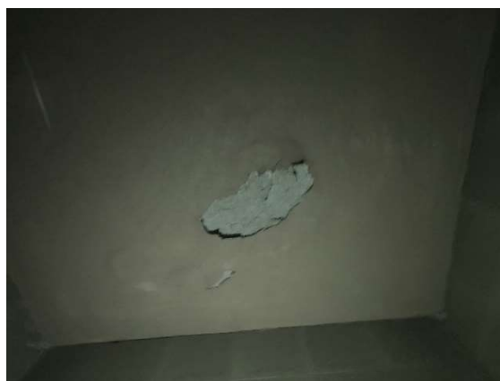
Foto 65 - Infiltração Teto
