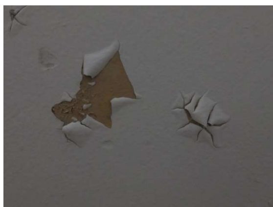
Foto 154 - Deterioração da pintura
