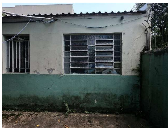
Foto 23 - Infiltração e fissuração
