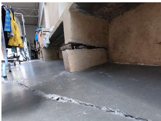
Foto 38 - Recalque de piso
