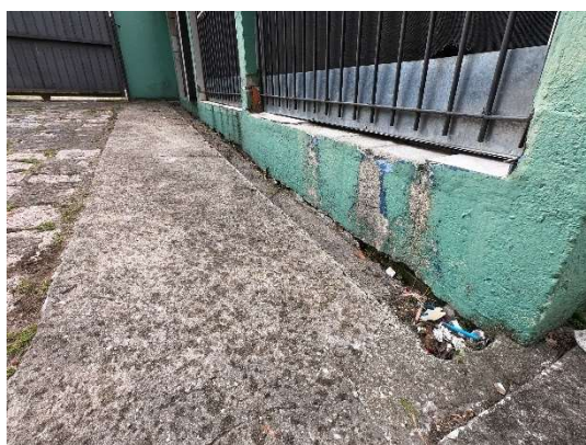
Quadro 9 - Registro fotográfico de Manifestações Patológicas na casa de bombas e no depósito de lixo
