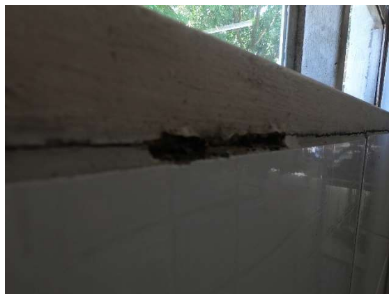
Foto 28 - Corrosão (Janela 02)
