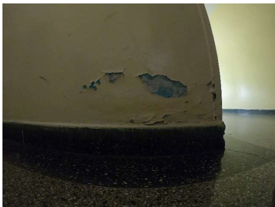
Foto 71 - Infiltração
