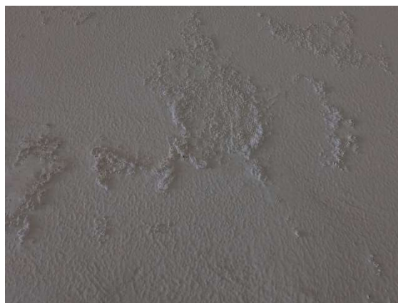
Foto 130 - Infiltração
