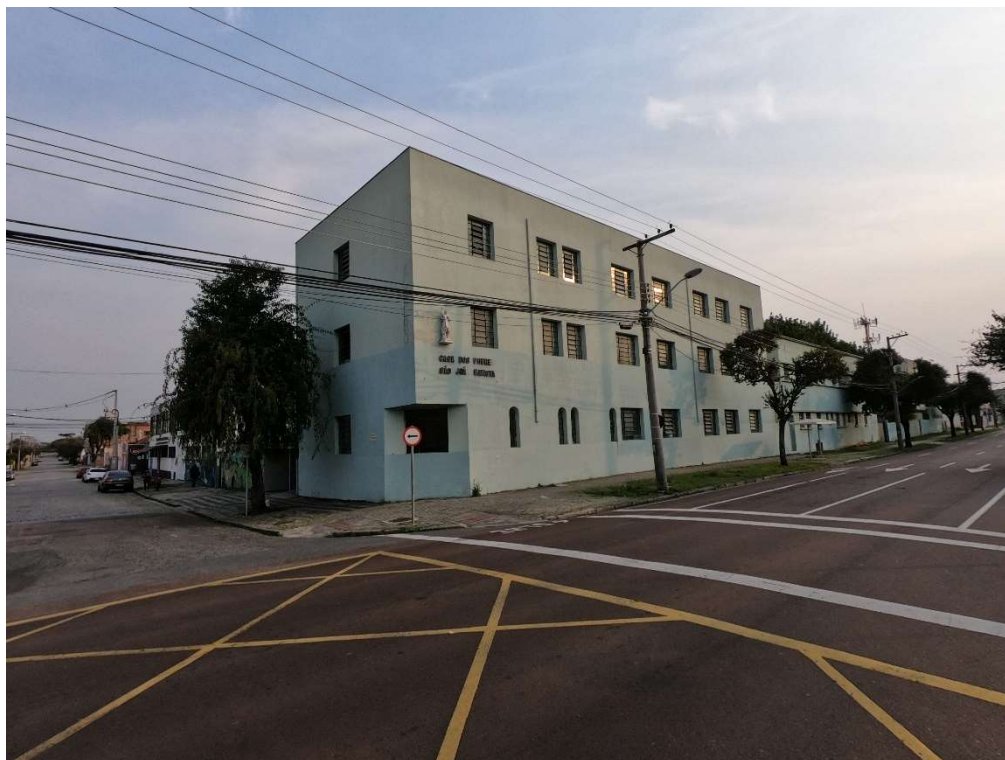
Foto 7 - Bloco 06 (Prédio principal)
