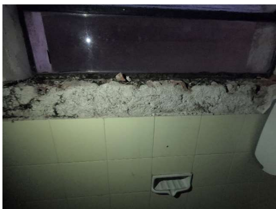
Foto 62 - Infiltração (Parede BWC)
