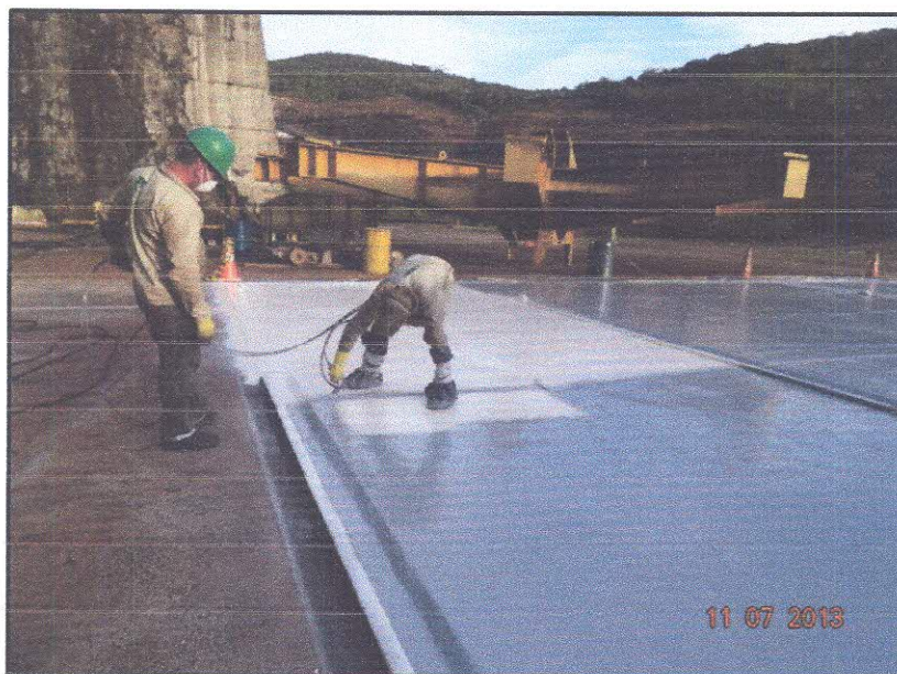
Figura 13. Aplicação da Impermeabilização
