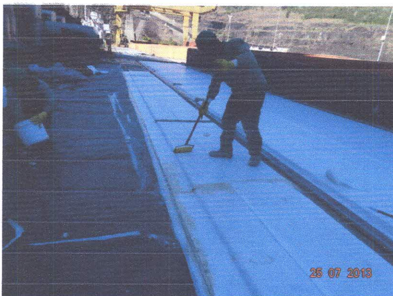
Figura 12. Acabamento com aplicação à Rolo
