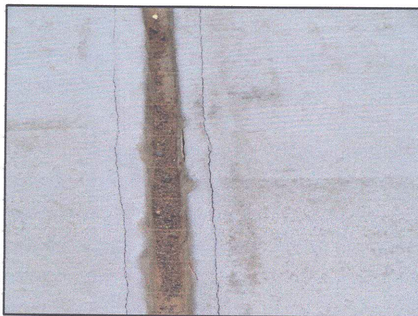
Figura 27. Detalhe da canaleta de drenagem
