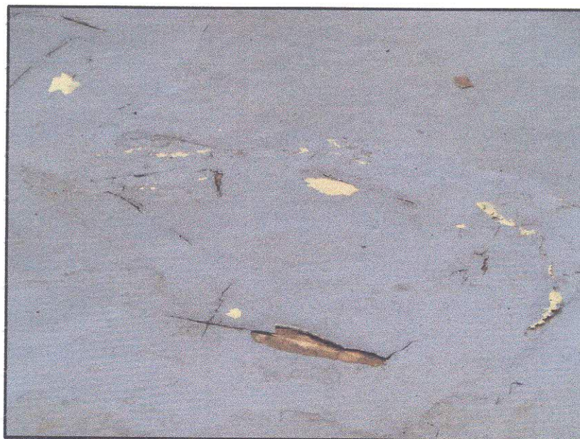
Figura 20. Desplacamento após formação de bolha
