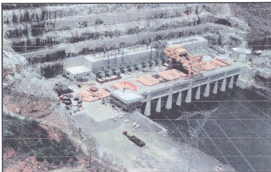
Figura 01. Usina Hidrelétrica GBM (MEMÓRIA TÉCNICA DE UHE GBM, 1995)
