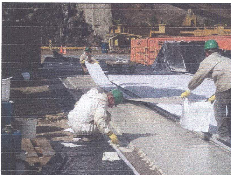
Figura 11. Instalação da Manta Estruturante
